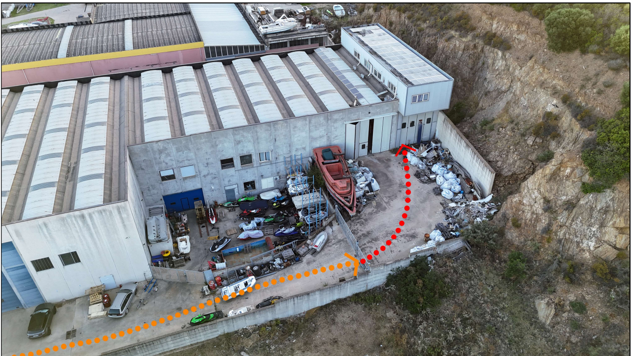
Fig. 6 – Dettaglio foto drone del percorso della servitù sulla corte del Sub. 60 fino al fabbricato (tratteggi color rosso).
