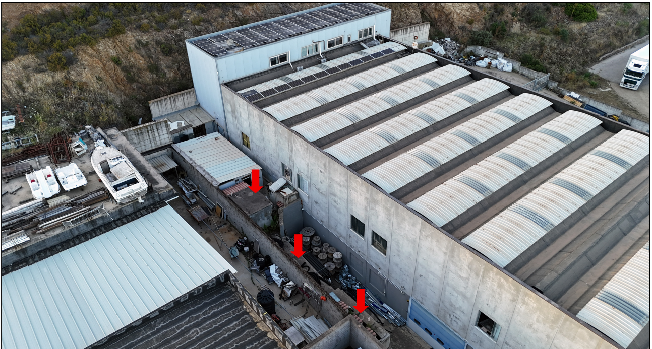
Fig. 2 - Vista dell'area (sub. 11) interessata da contatori, vasche di riserva idrica e servizi comuni.
