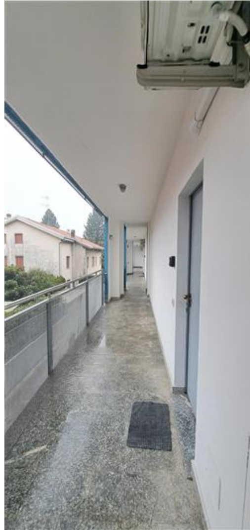
ballatoio di accesso alle unità abitative
