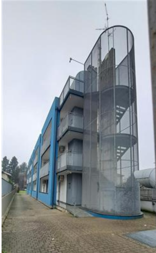
scala di accesso ai ballatoi
