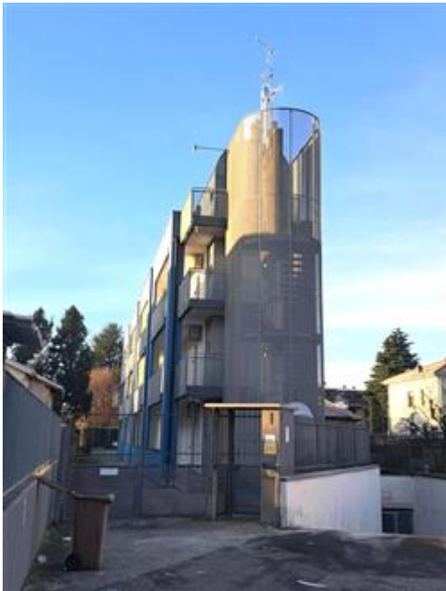
accessi all'edificio, pedonale e carrabile
