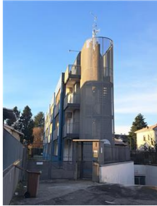
accessi all'edificio, pedonale e carrabile
