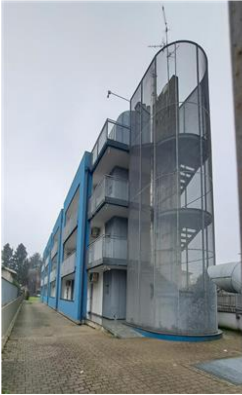
scala di accesso ai ballatoi
