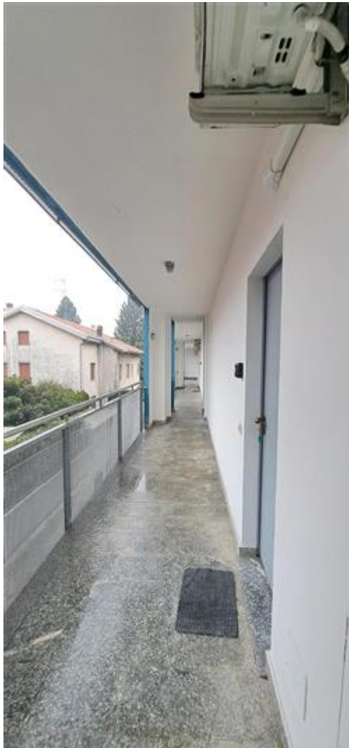
ballatoio di accesso alle unità abitative
