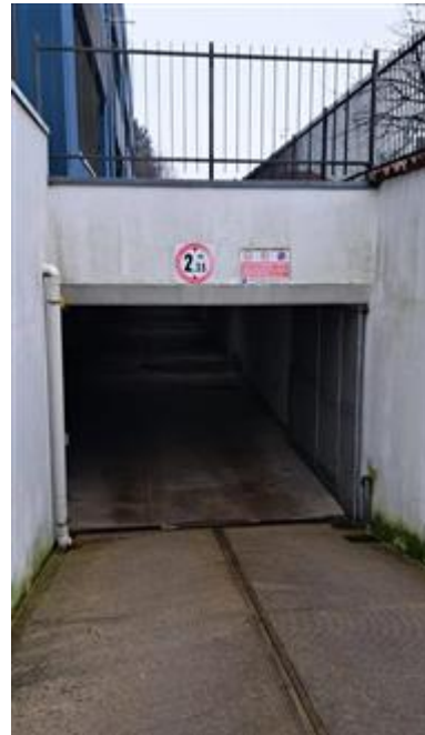
vano di accesso al piano interrato
