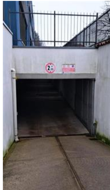
vano di accesso al piano interrato
