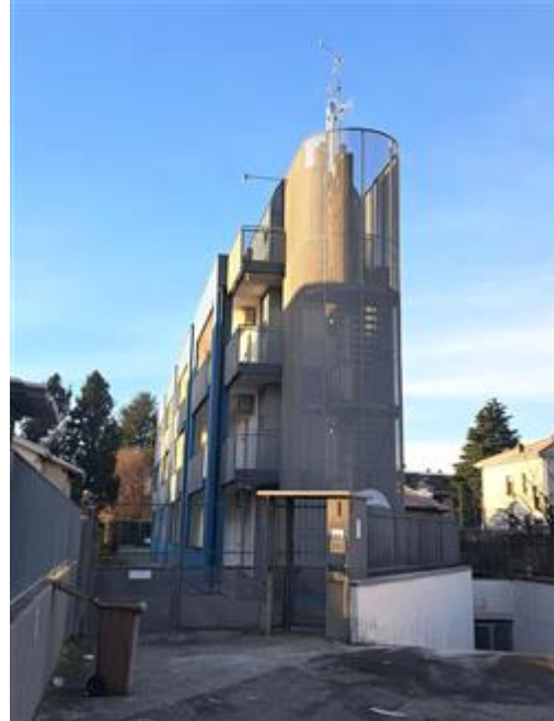
accessi all'edificio, pedonale e carrabile
