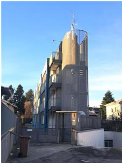
accessi all'edificio, pedonale e carrabile
