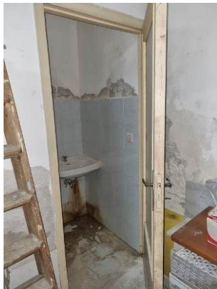
Foto n. 41 P.T. - Locale wc nel Locale Box.
