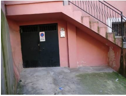
Foto n. 35 Piano Terra - Locale Box.
