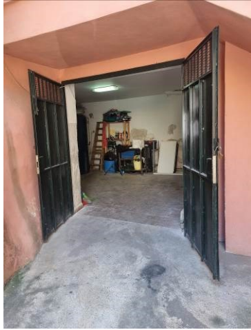
Foto n. 36 P.T. - Locale Box.
