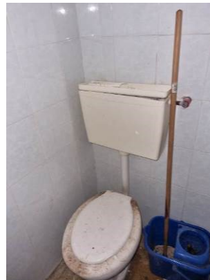
Foto n. 42 P.T. - Locale wc nel Locale Box.
