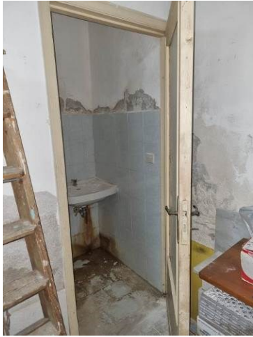
Foto n. 41 P.T. - Locale wc nel Locale Box.
