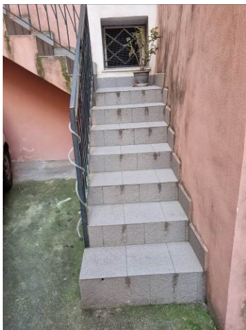
Foto n. 2 Il corpo scala esterno.
