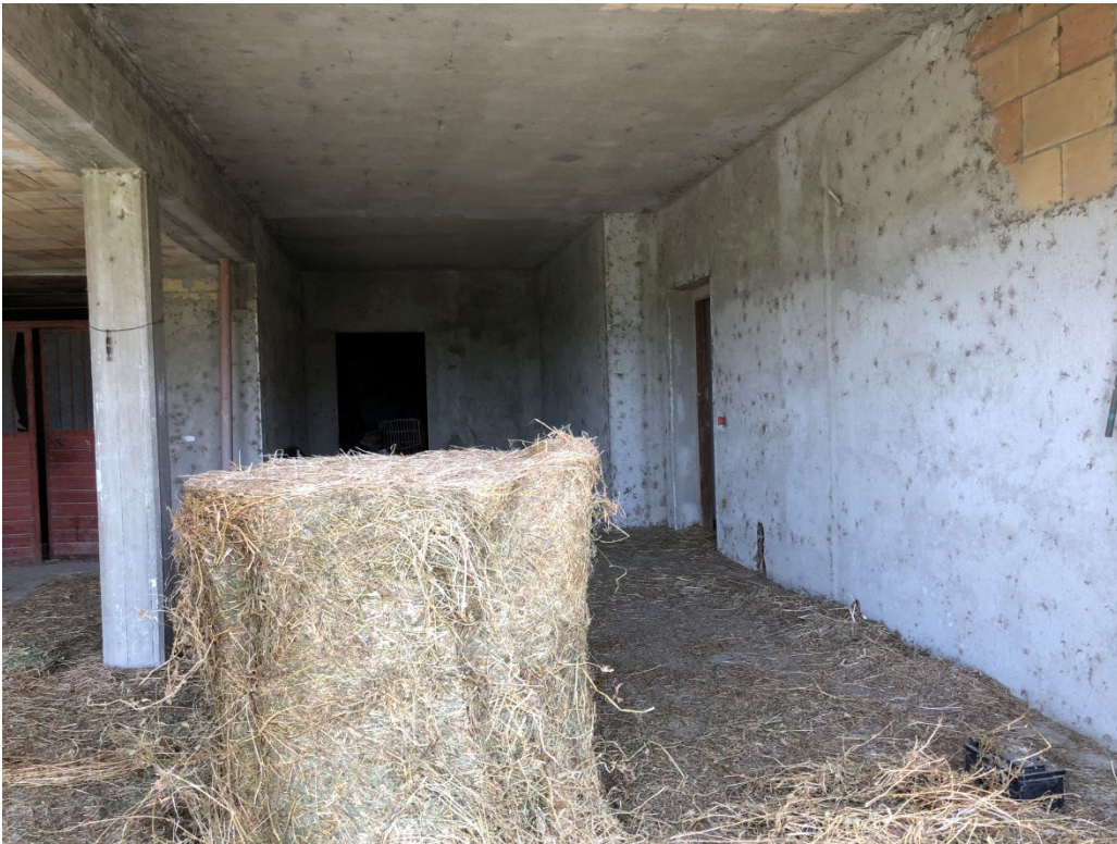
FOTO 7: NUOVO EDIFICIO RURALE – INTERNO PIANO SEMINTERRATO
