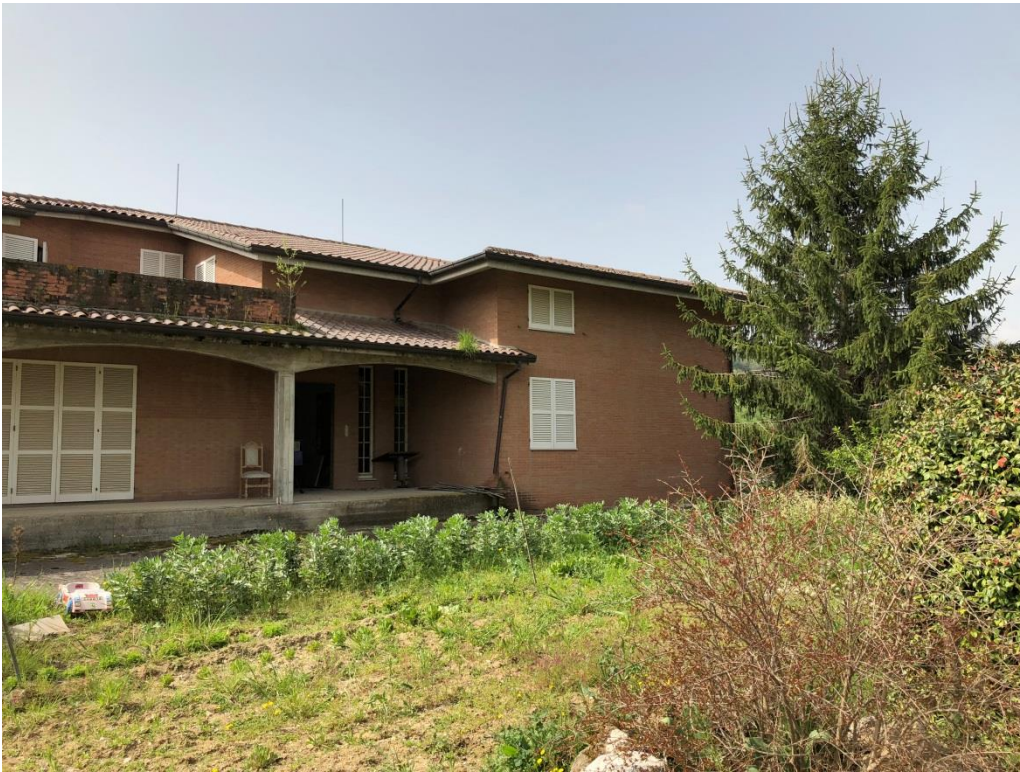
FOTO 5: NUOVO EDIFICIO RURALE AL GREZZO
