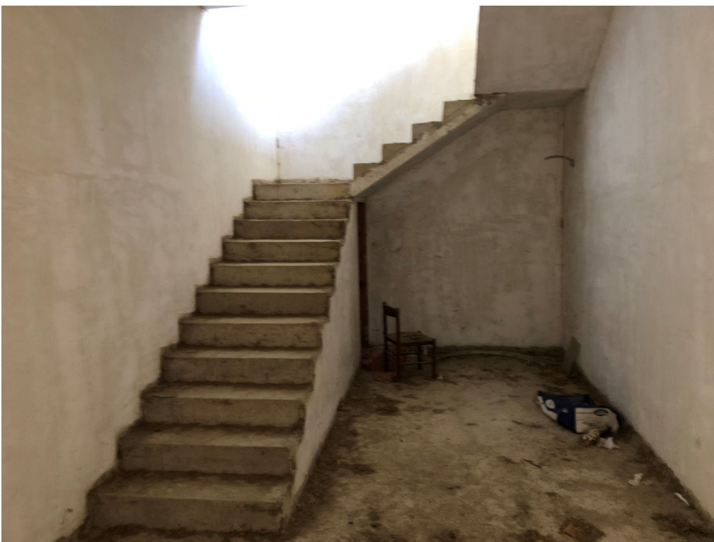
FOTO 8: NUOVO EDIFICIO RURALE – INTERNO SCALA AL PIANO SEMINTERRATO
