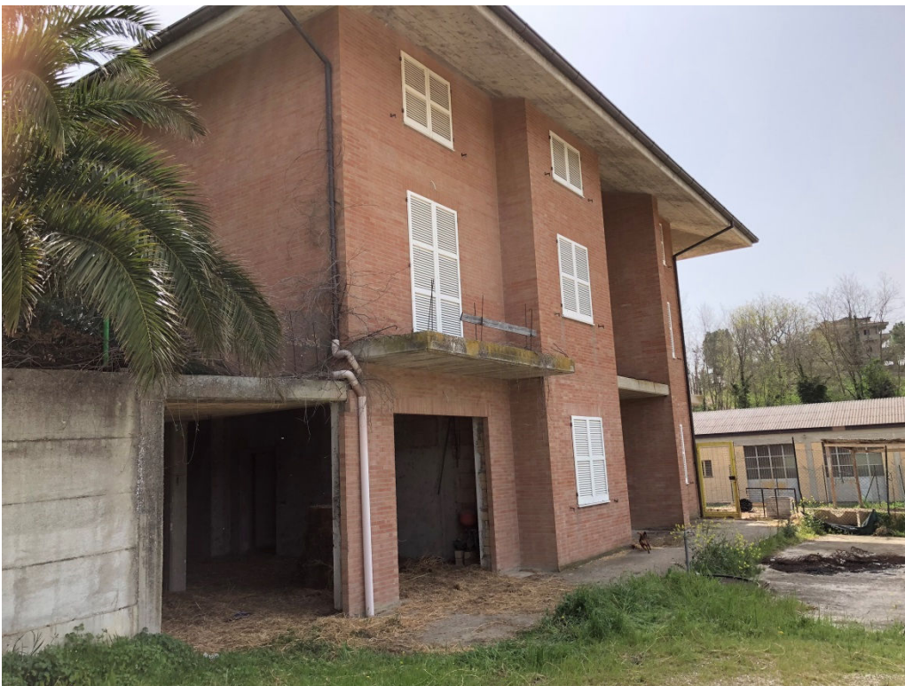
FOTO 6: NUOVO EDIFICIO RURALE AL GREZZO
