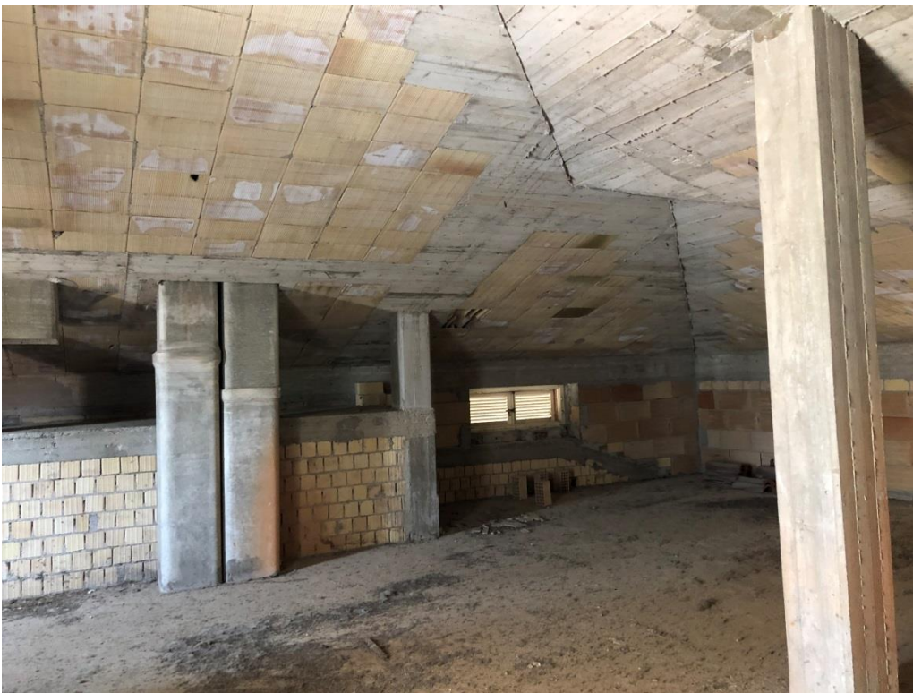
FOTO 10: NUOVO EDIFICIO RURALE – INTERNO PIANO PRIMO SOTTOTETTO
