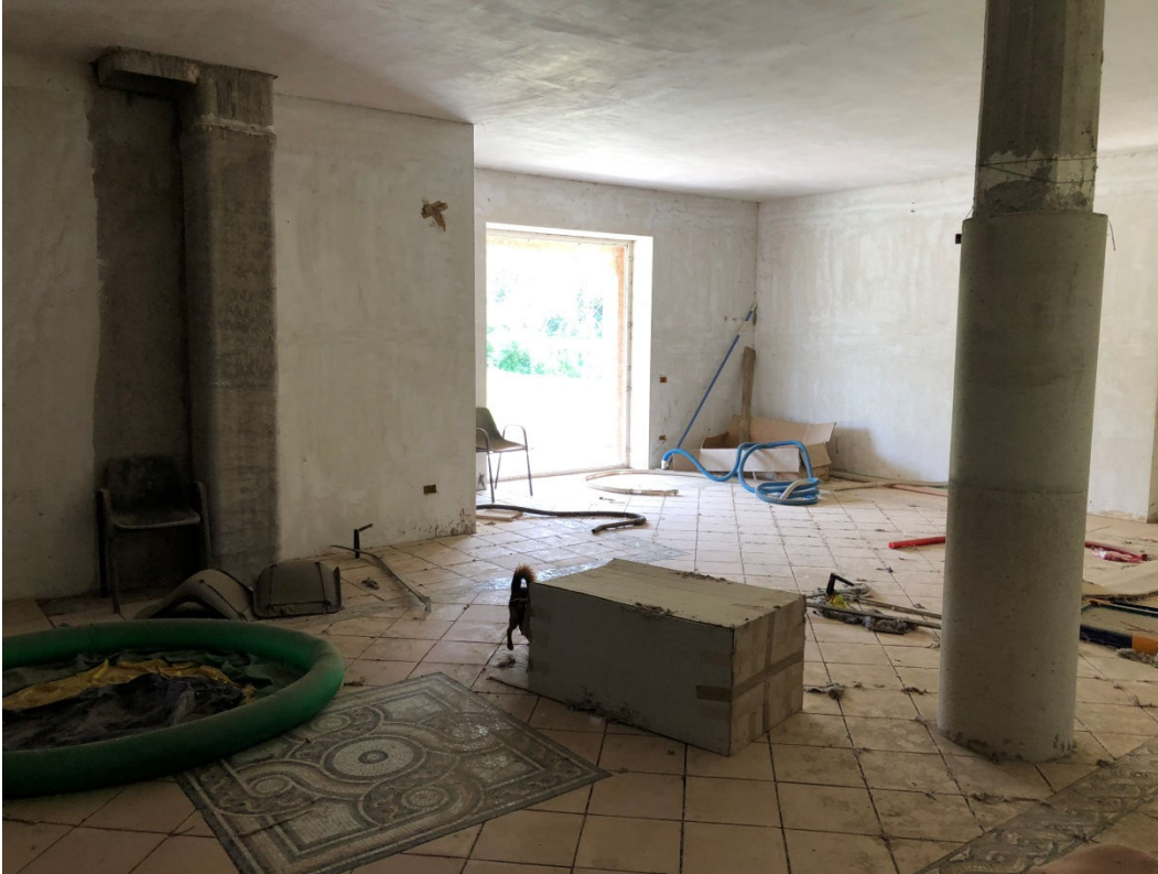
FOTO 9: NUOVO EDIFICIO RURALE – INTERNO PIANO TERRA
