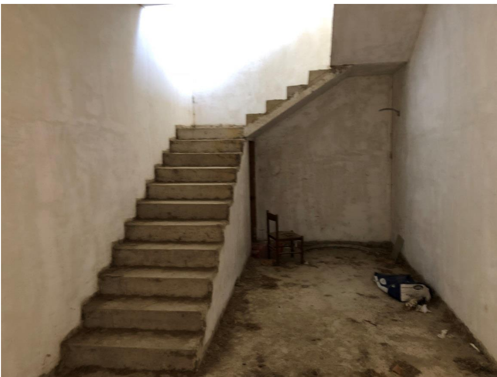
FOTO 8: NUOVO EDIFICIO RURALE – INTERNO SCALA AL PIANO SEMINTERRATO
