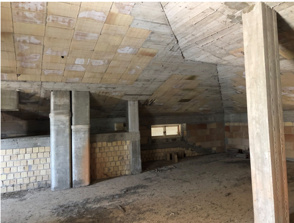
FOTO 10: NUOVO EDIFICIO RURALE – INTERNO PIANO PRIMO SOTTOTETTO
