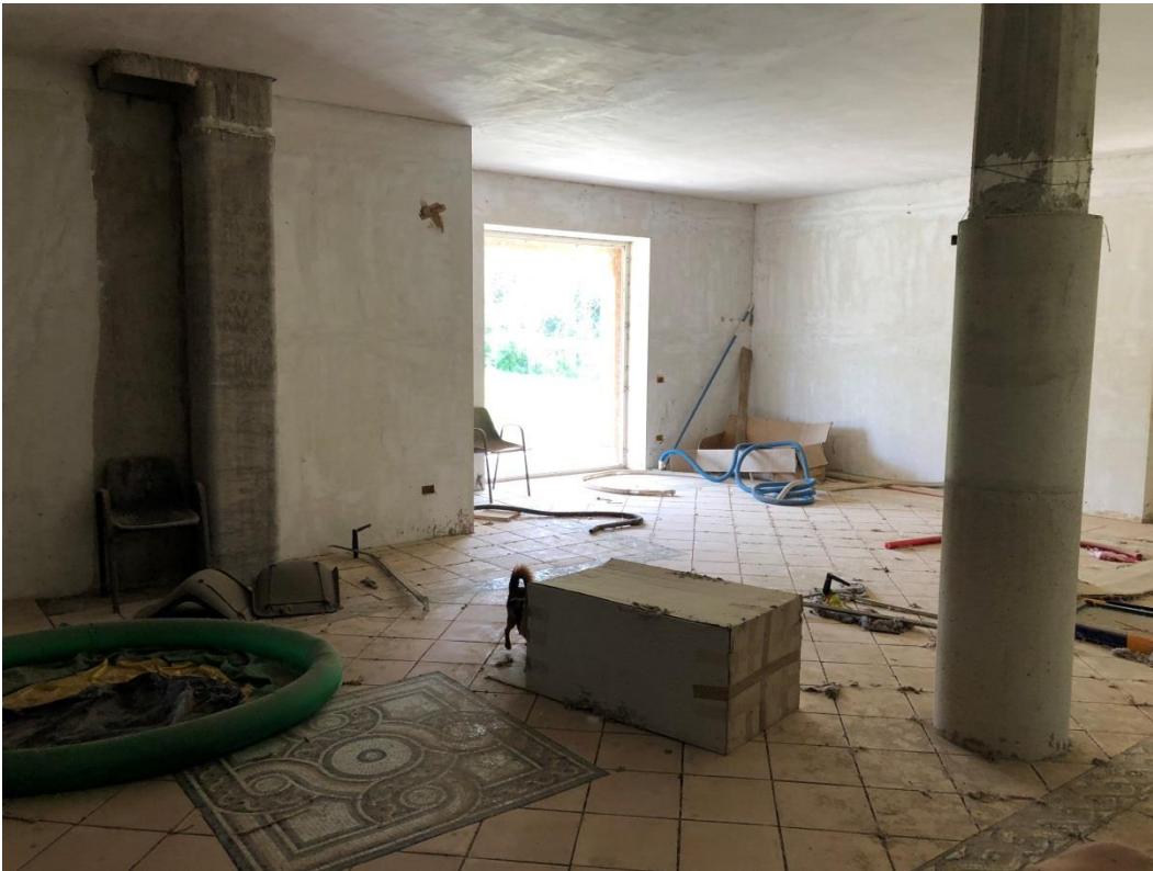
FOTO 9: NUOVO EDIFICIO RURALE – INTERNO PIANO TERRA
