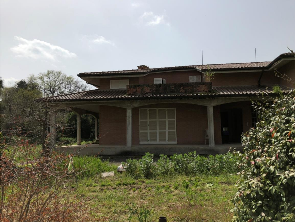
FOTO 4: NUOVO EDIFICIO RURALE AL GREZZO
