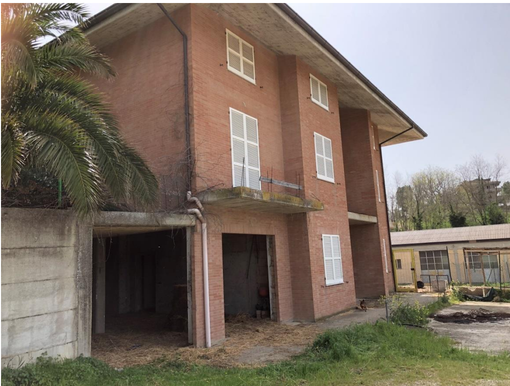
FOTO 6: NUOVO EDIFICIO RURALE AL GREZZO
