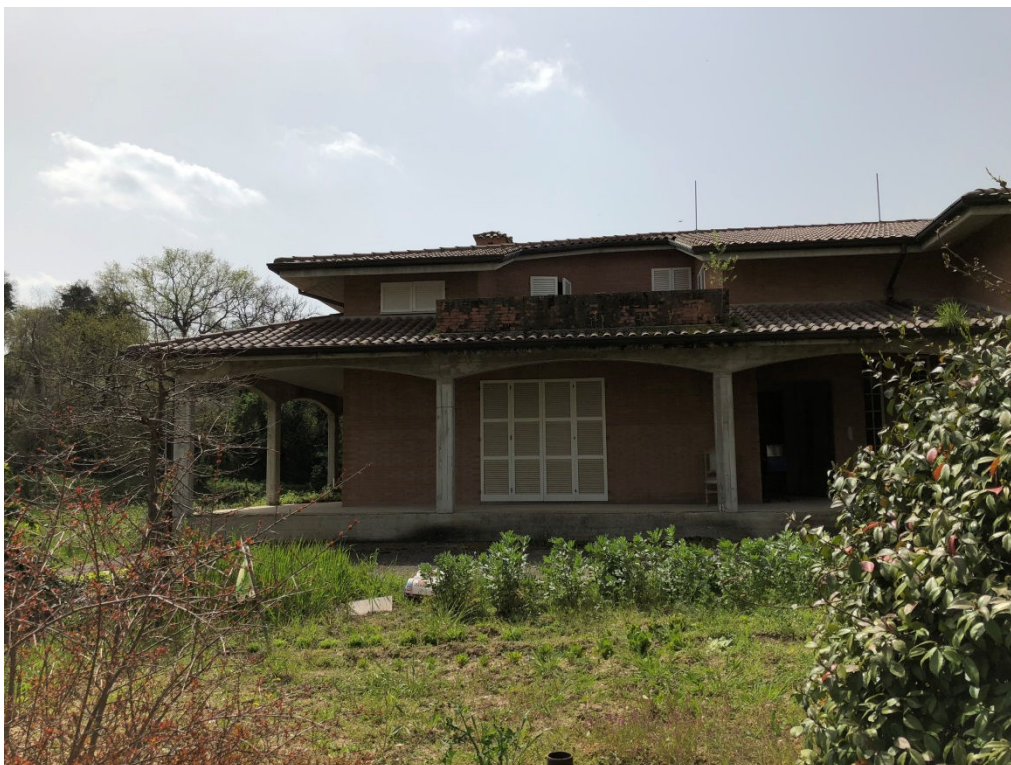
FOTO 4: NUOVO EDIFICIO RURALE AL GREZZO
