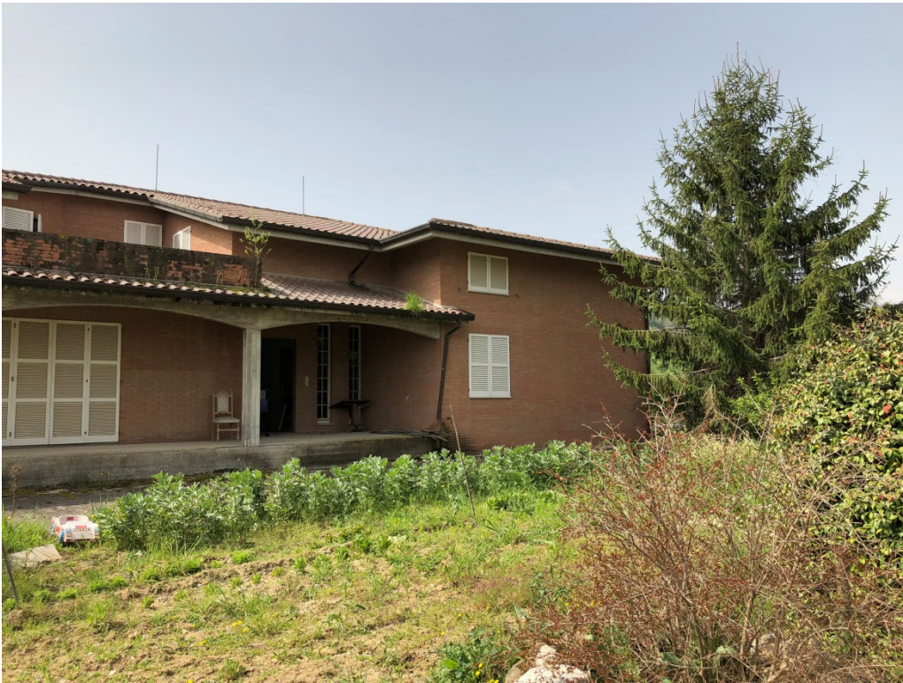
FOTO 5: NUOVO EDIFICIO RURALE AL GREZZO
