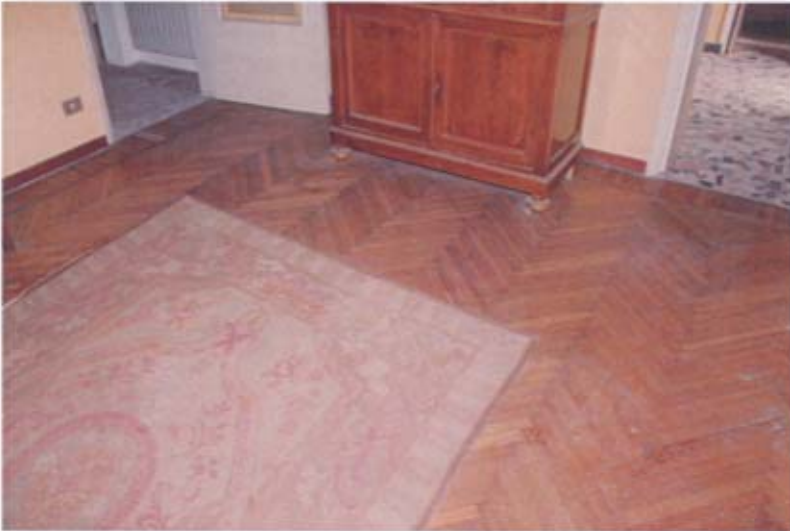
Foto 13: Part. pavimento sala pranzo
