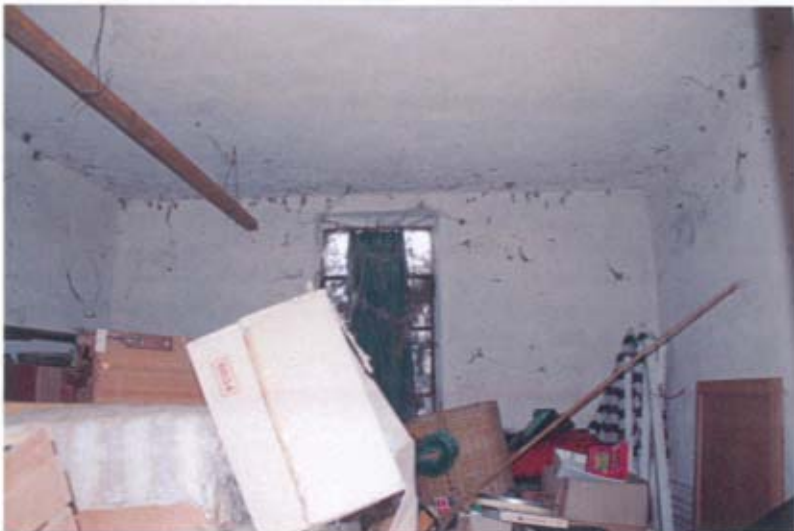
Foto 48: Interno locale cantina
