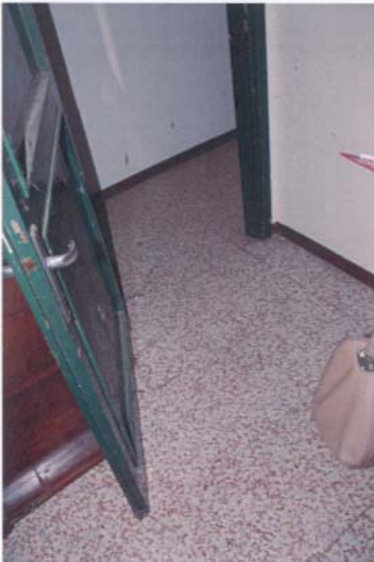
Foto 45: Part. pavimentazione stanze da letto
