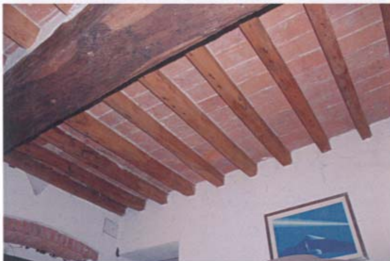
Foto 39: Part. solaio d'interpiano soggiorno
