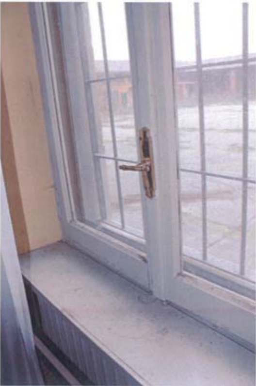
Foto 11: Part. serramenti esterni
