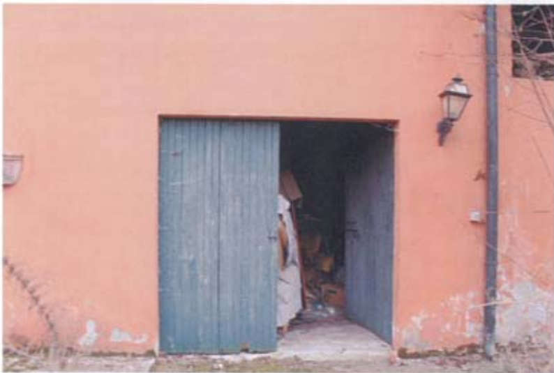
Foto 47: Porta ingresso cantina- fronte Nord
