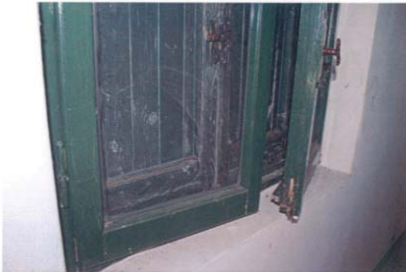
Foto 46: Part. serramenti esterni
