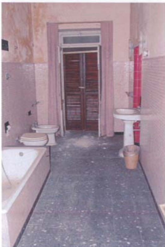
Foto 18: Bagno primo piano
