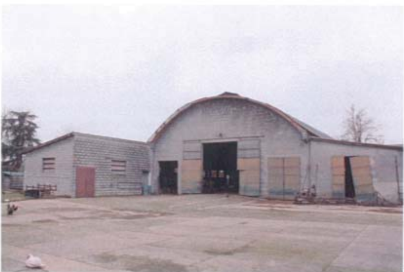
Foto 73: Fabbricati rurali – Fronte Ovest
