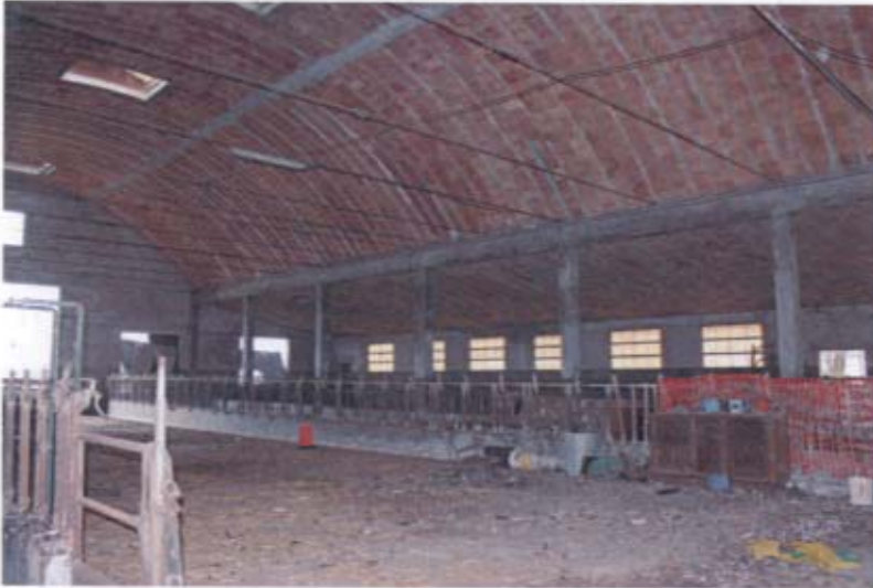
Foto 74: Fabbricati ex stalla – Mapp. 58/503
