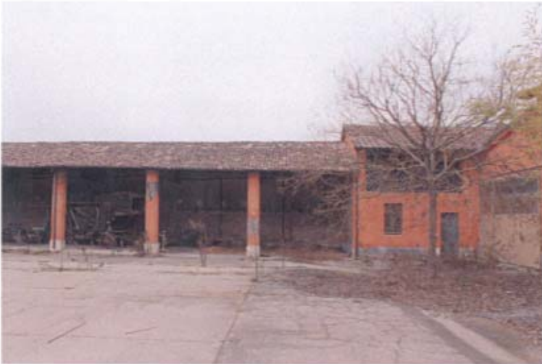
Foto 65: Fabbricati rurali – Fronte Est
