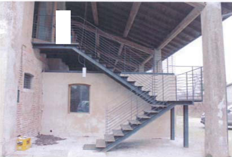
Foto 83: Scala accesso al piano superiore
