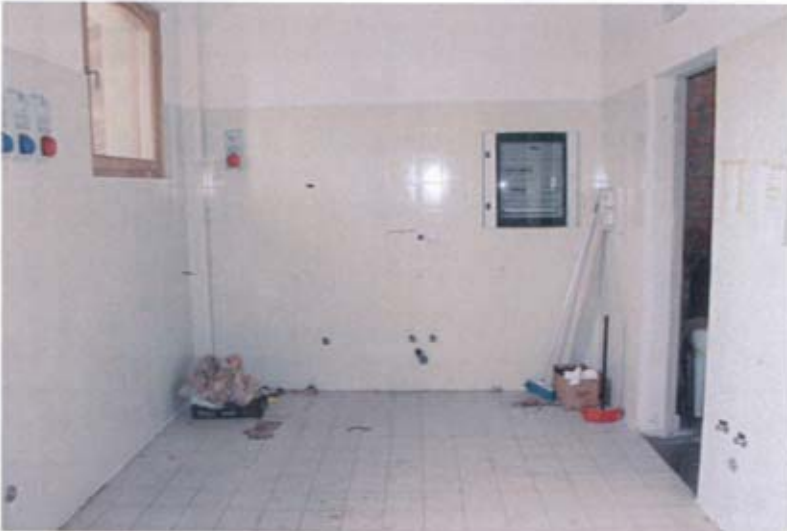
Foto 90: Locale di servizio - 1° piano
