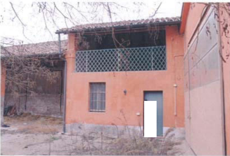
Foto 69: Fabbricati rurali – Fronte Ovest
