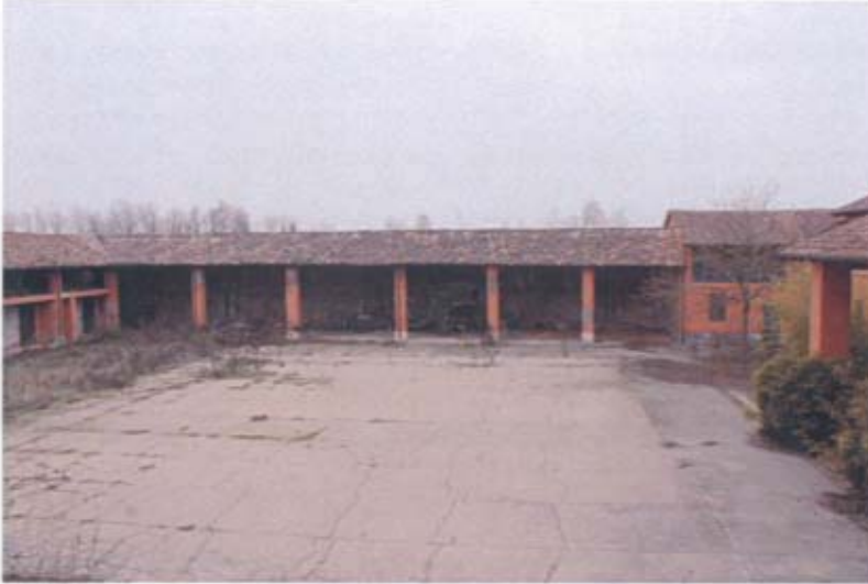
Foto 63: Area esclusiva 27/507 – cortile interno
