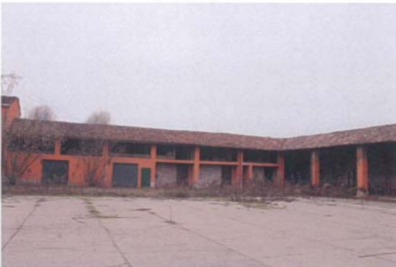
Foto 64: Fabbricati rurali – Fronte Nord
