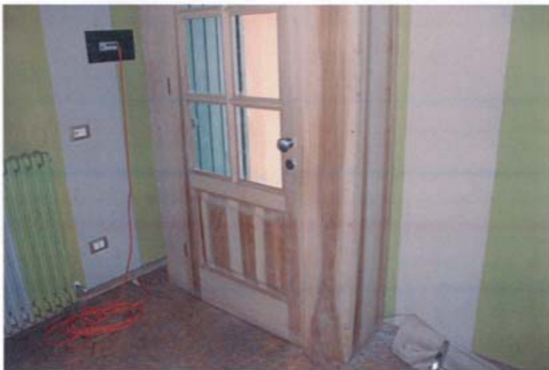
Foto 100: Part. serramento id'ingresso
