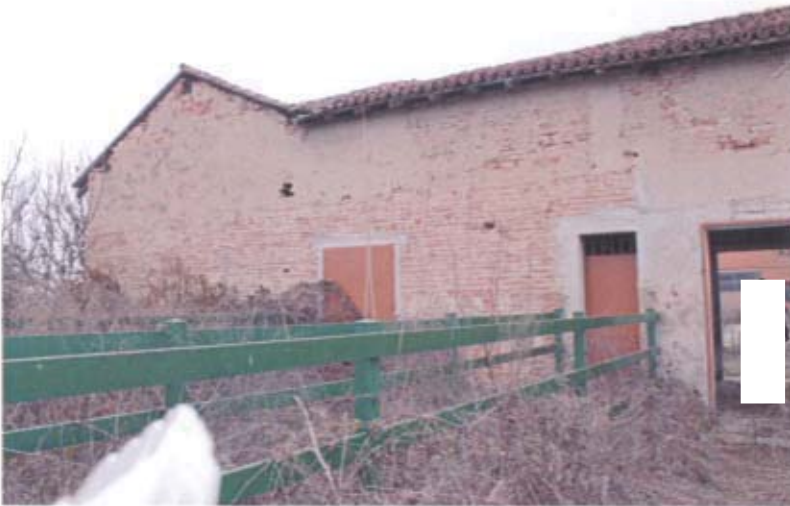
Foto 66: Fabbricati rurali – Fronte Sud
