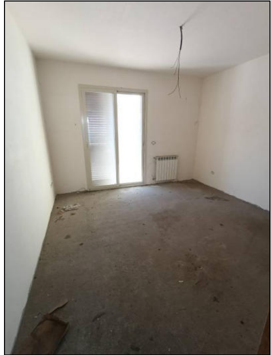
FOTO 10: Vano 2, prospiciente su via Umberto I.
