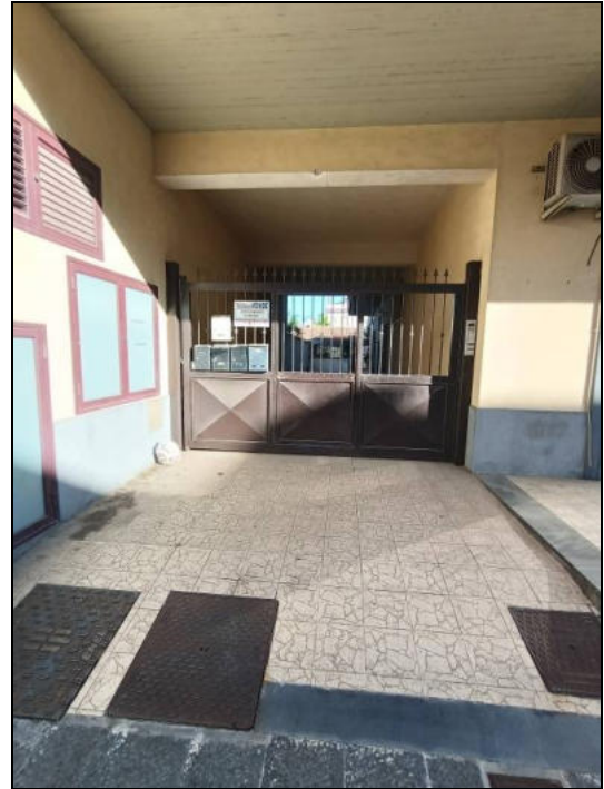
FOTO 2: Cancellone automatico d'ingresso del fabbricato.
