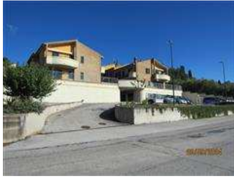
Vista del fabbricato dalla strada provinciale
