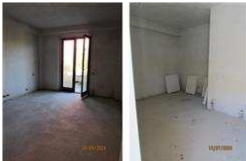
Locale destinato a camera doppia e termosifoni depositati nel
