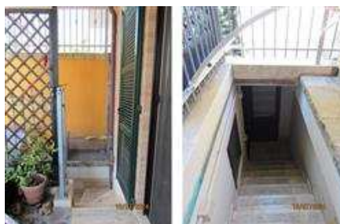
Scala esterna di accesso dalla corte dell'appartamento
