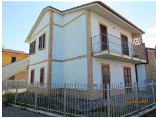
Vista della corte da Nord-Est
