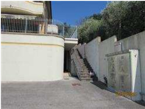
Vista del passaggio comune di ingresso
