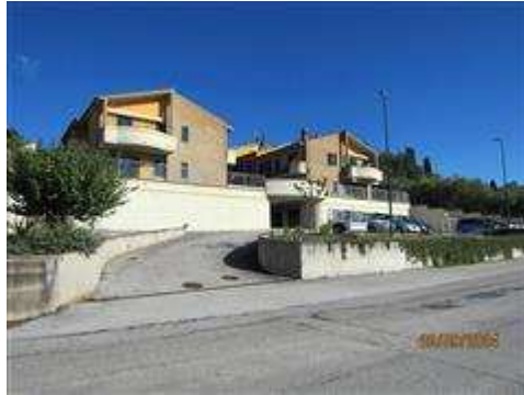
Vista del fabbricato dalla strada provinciale
