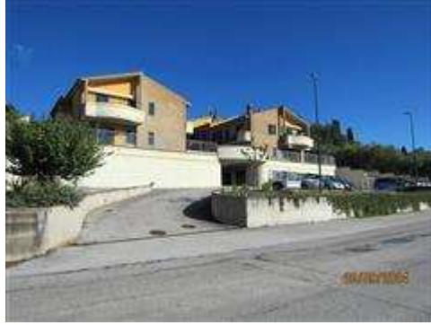
Vista del fabbricato dalla strada provinciale
