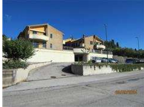
Vista del fabbricato dalla strada provinciale
