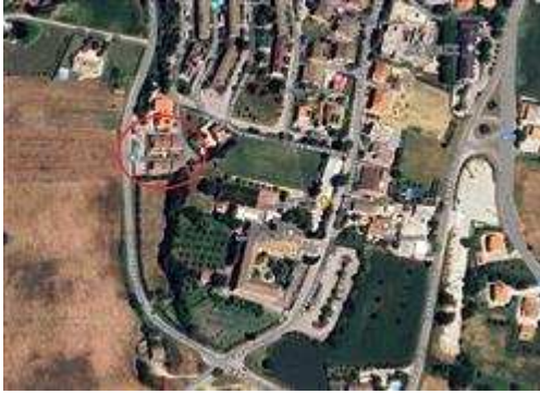
Localizzazione su Google Maps del fabbricato
