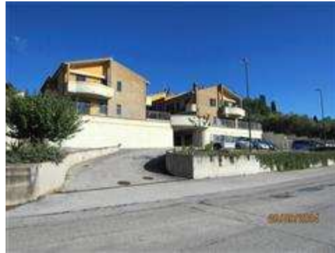
Vista del fabbricato dalla strada provinciale
