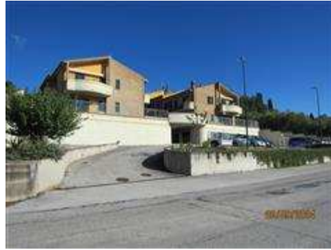
Vista del fabbricato dalla strada provinciale
