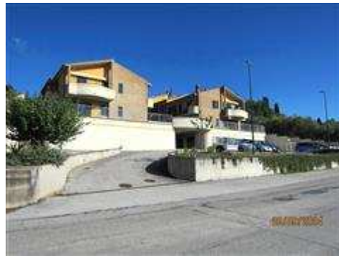
Vista del fabbricato dalla strada provinciale
