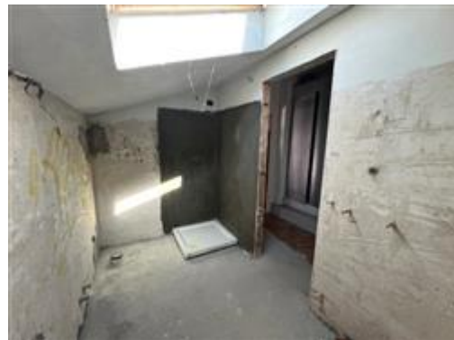
vista interna w.c.
