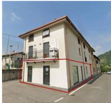
vista esterna palazzina con evidenziata la porzione interessata
