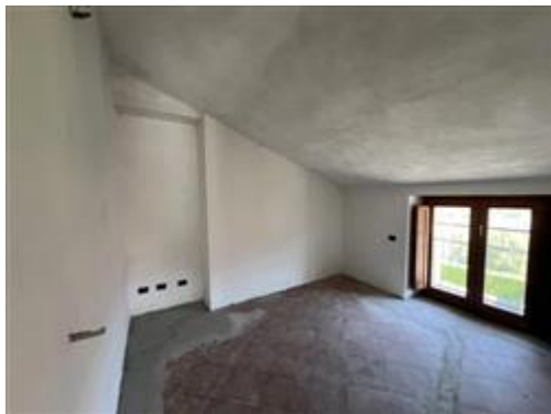
vista interna bagno
