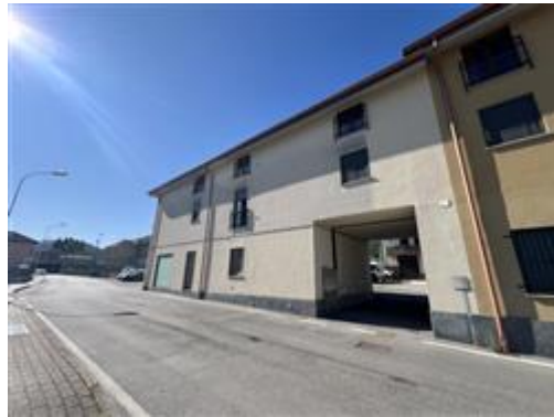
vista intero edificio laterale
