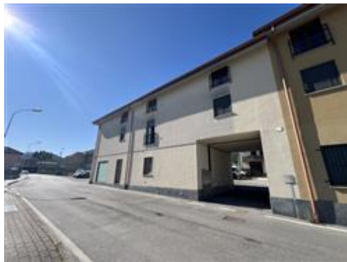
vista laterale della palazzina
