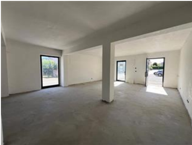
vista interna stato di fatto
