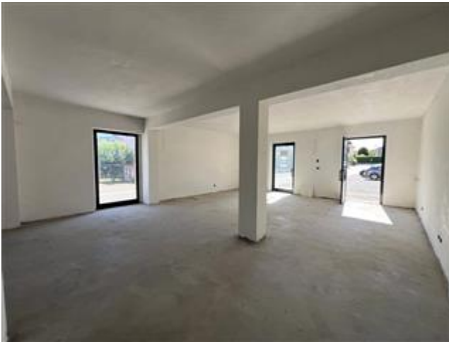
vista interna stato di fatto
