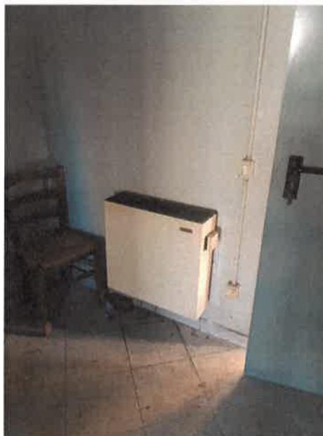
Foto 30 ventilconvettore
