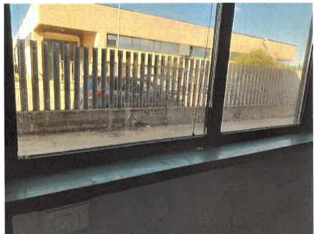
Foto 25-26-27-28 stato di manutenzione
