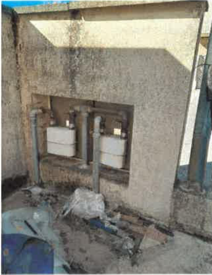
Foto 44 Nicchie con contatori metano
