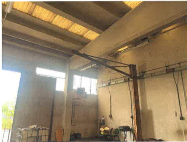
Foto 3 particolare capriata e manto
