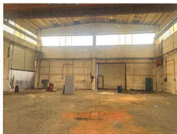
Foto 10 vista carpenteria, capriata, portone, tegoli, pilastri
