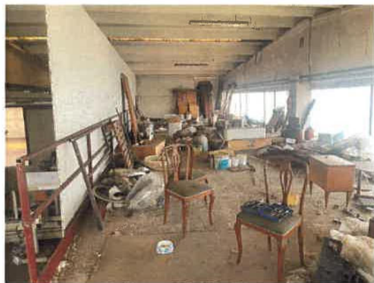
Foto 42-43 Magazzino e scala in ferro
