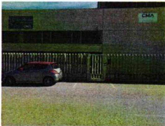
Foto 45 Accesso pedonale civico 8
