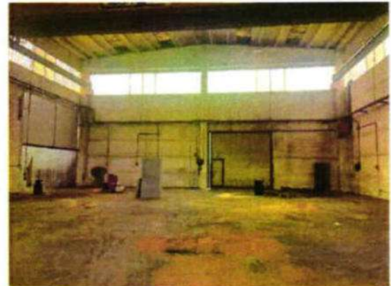
Foto 10 vista carpenteria, capriata, portone, tegoli, pilastri
