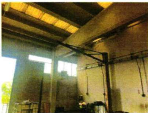
Foto 3 particolare capriata e manto
