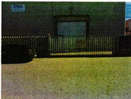
Foto 47 Accesso carraio snc
