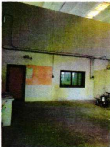
Foto 21 officina, porta e finestra vano ufficio
