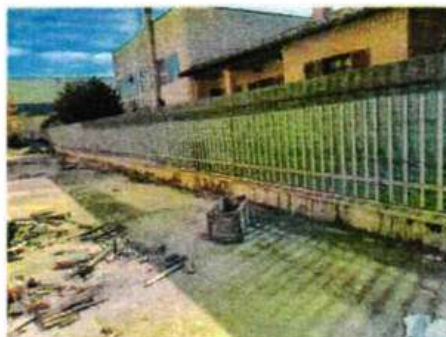
Foto 51-52 Stato di manutenzione
