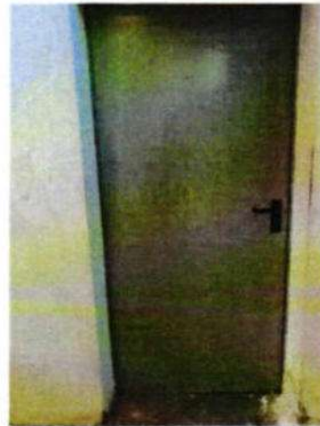
Foto 22 porta accesso spogliatoio 2
