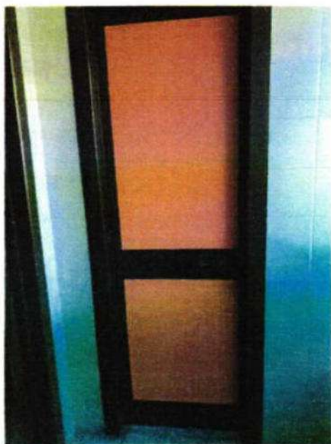
Foto 23 porta particolare servizi
