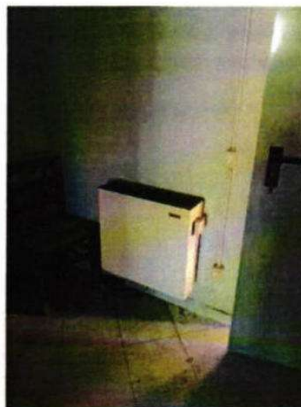
Foto 30 ventilconvettore
