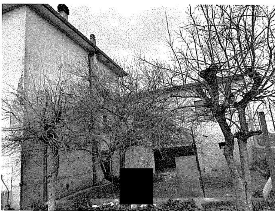
Foto 18: prospetto posteriore autorimessa adiacente alla abitazione
