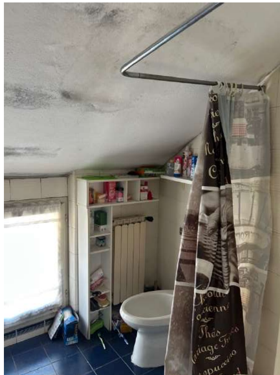
Foto 20 e 21: P2 bagno, l'umidità presente è dovuta sia ad infiltrazioni di acqua piovana sia a un insufficiente ricambio d'aria
