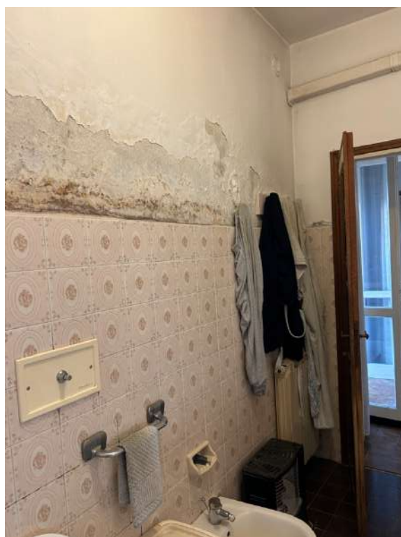
Foto 8 e 9: P1 bagno. Si evidenziano perdite dall'impianto di scarico e forse anche di adduzione acqua
