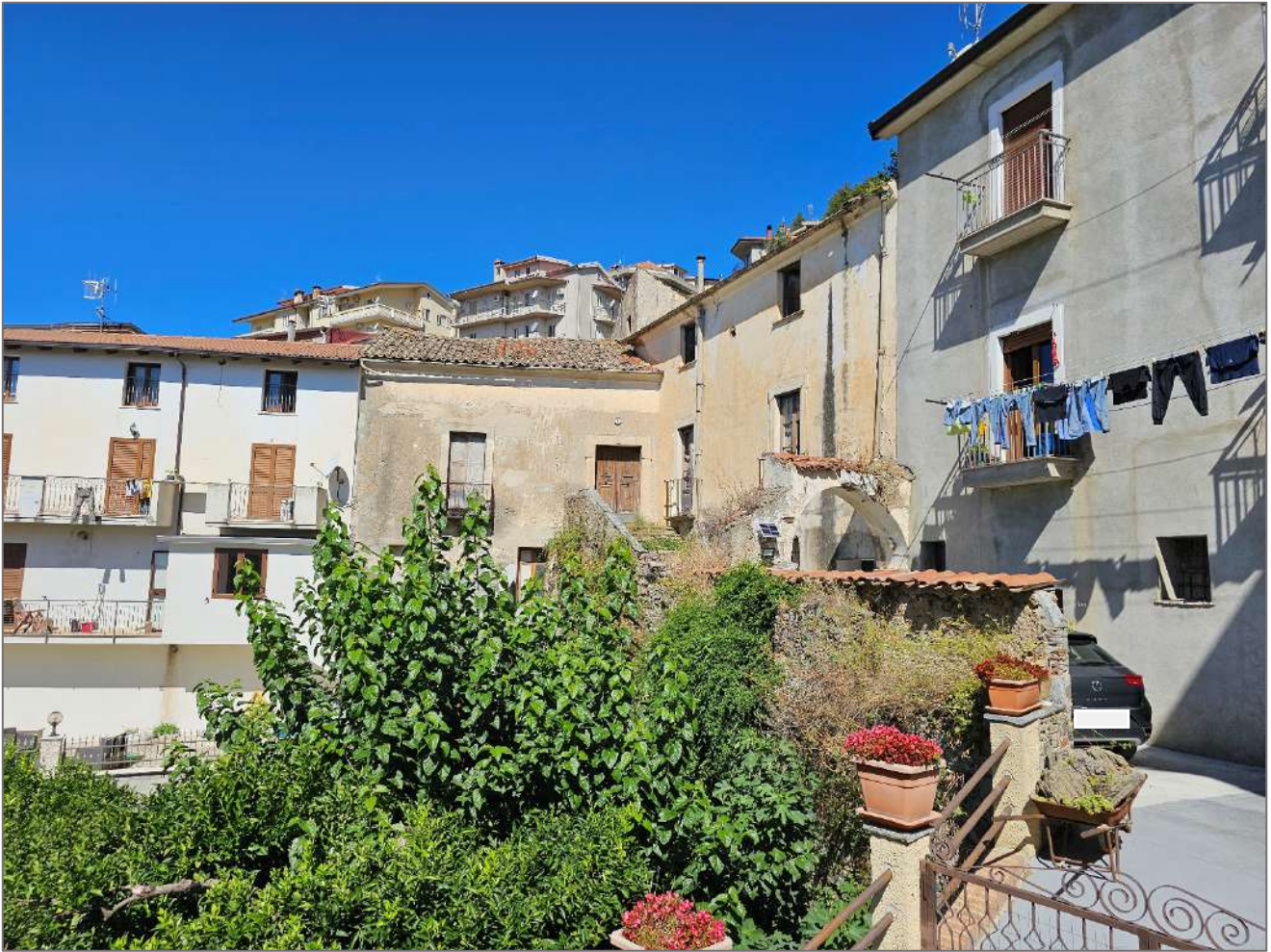
Foto 4, 5 – Fabbricati dove sono dislocati i beni oggetto di pignoramento. Riprese dal cortile interno
