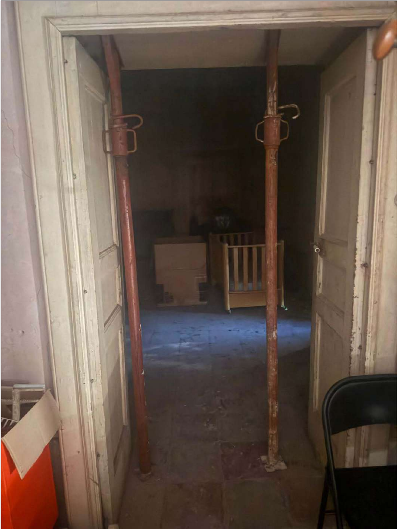
Foto 56– Particolare intervento di tamponamento in corrispondenza delle bucaure nella muratura
