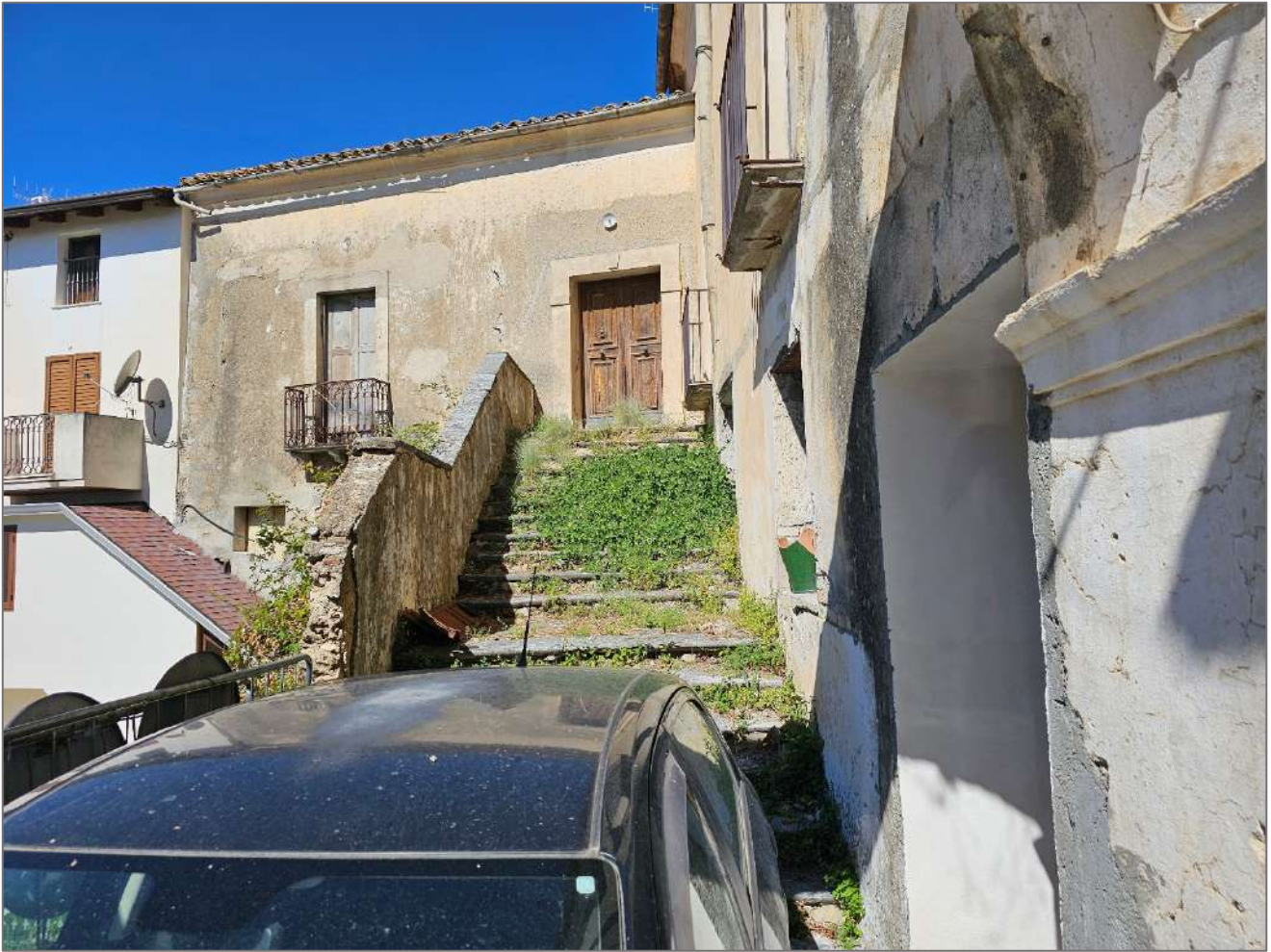
Foto 20, 21 – Bene censito nel NCEU del Comune di Taverna al foglio 43, particella 238, sub 25. Scala esterna di ingresso.
