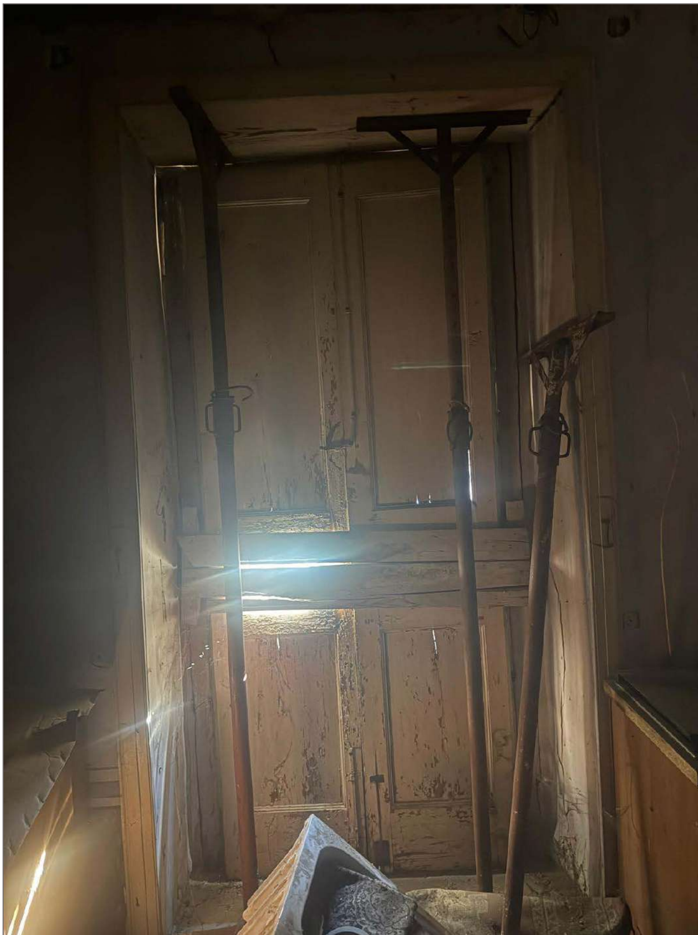
Foto 57– Particolare intervento di tamponamento in corrispondenza delle bucatore nella muratura
