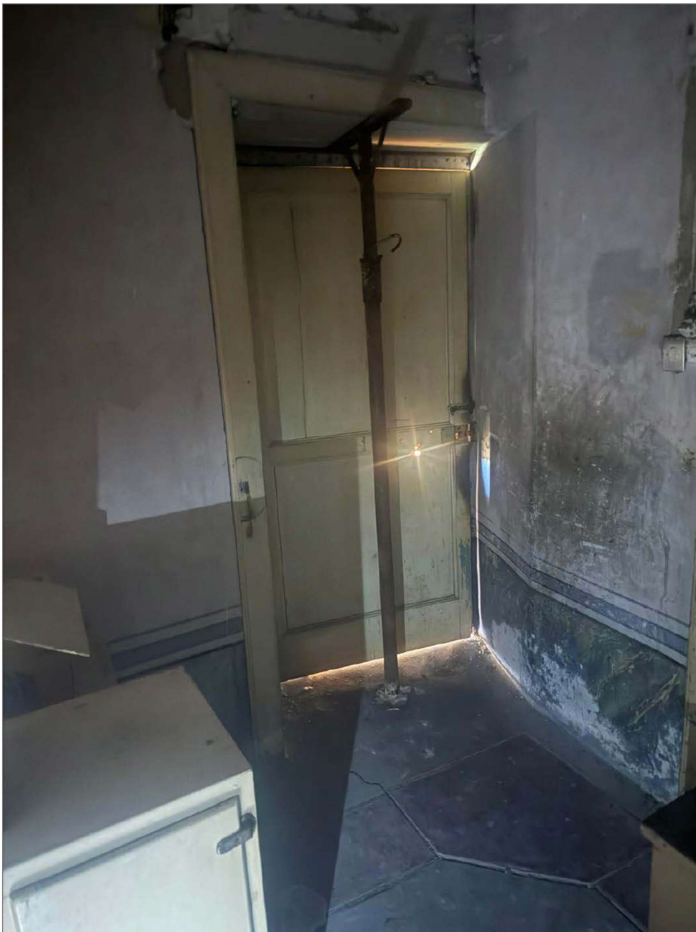
Foto 59– Particolare intervento di tamponamento in corrispondenza delle bucaure nella muratura
