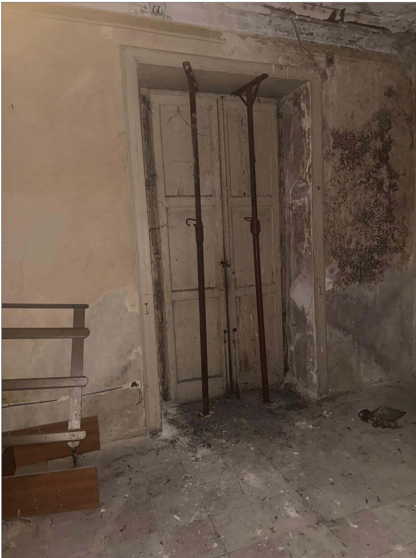
Foto 60– Particolare intervento di tamponamento in corrispondenza delle bucaure nella muratura
