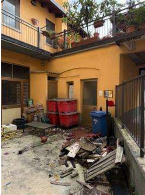
cortile esterno e ripostiglio con caldaia/boiler
