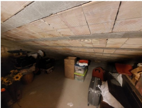
Foto n.13 – Vista interna soffitta
