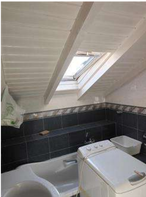
servizio igienico piano mansardato
