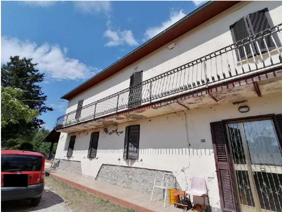
Immobile principale prospetto fronte strada
