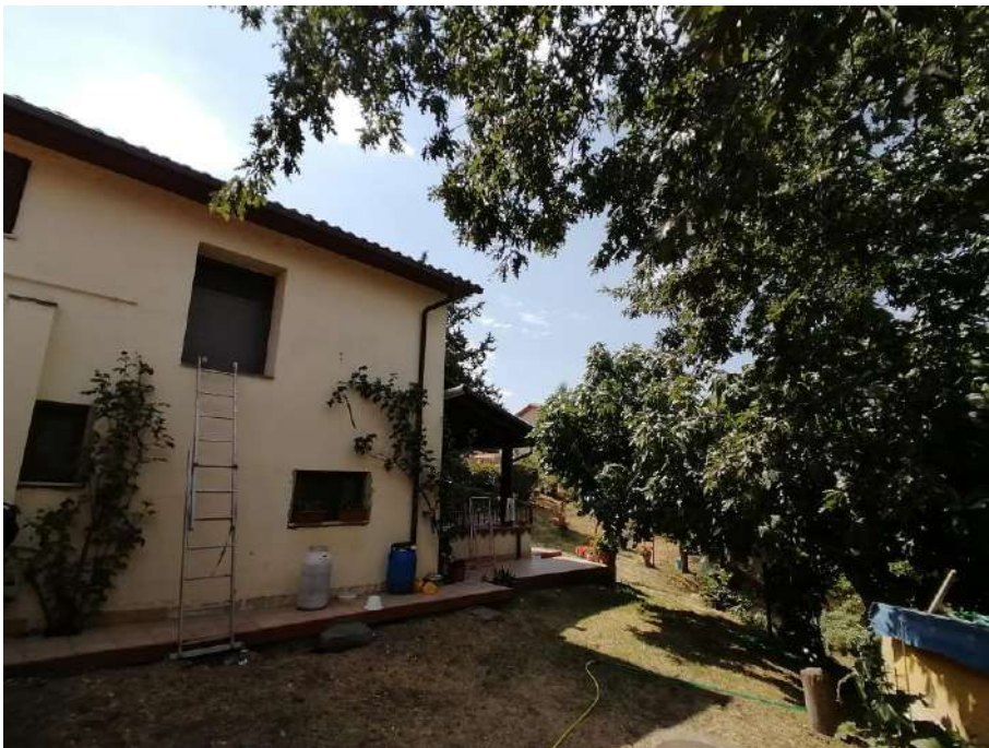
Immobile n.1 accesso esterno al ripostiglio
