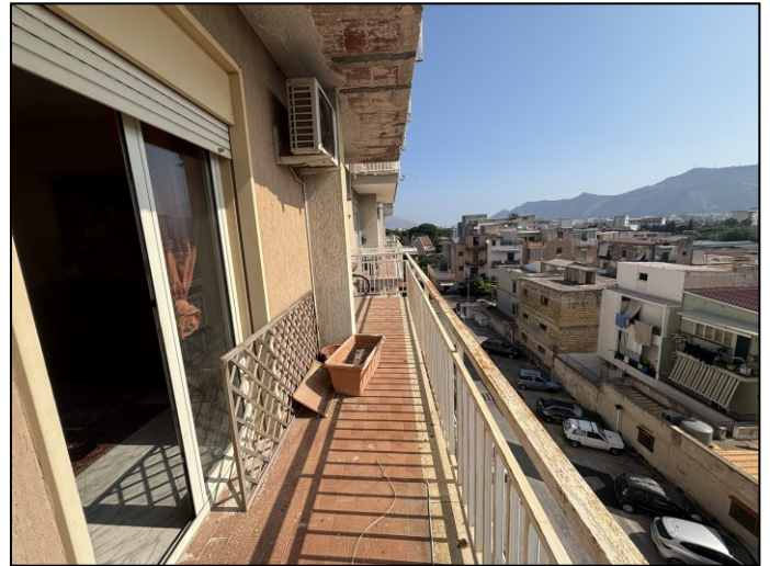
Foto 41 – Balcone lato est
