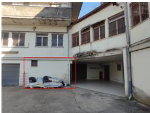
Rimessa prospetto NW
