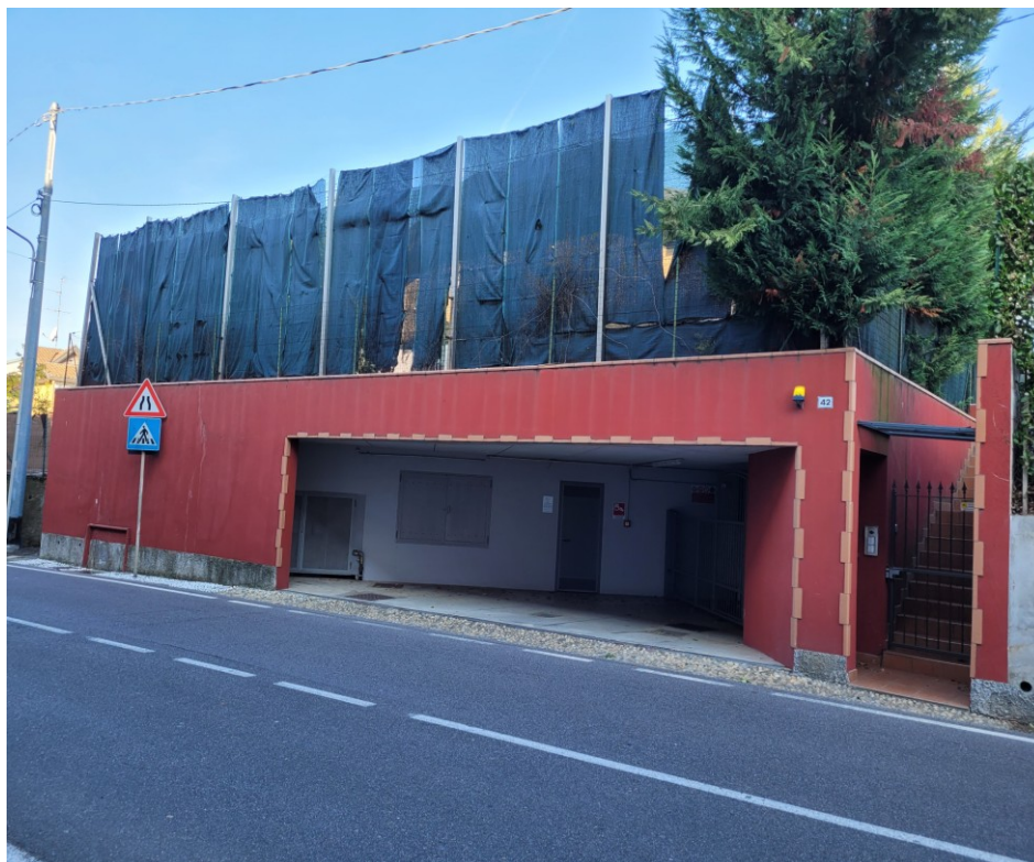
Ingresso carraio e pedonale al compendio sulla via Rampoldi
