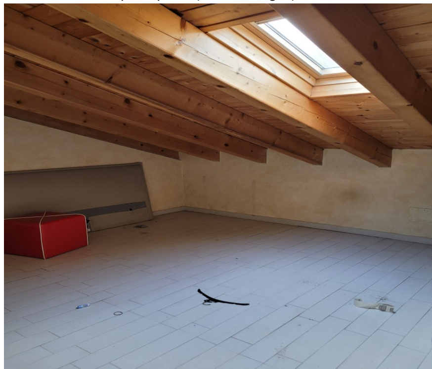
Locale sottotetto al piano primo
