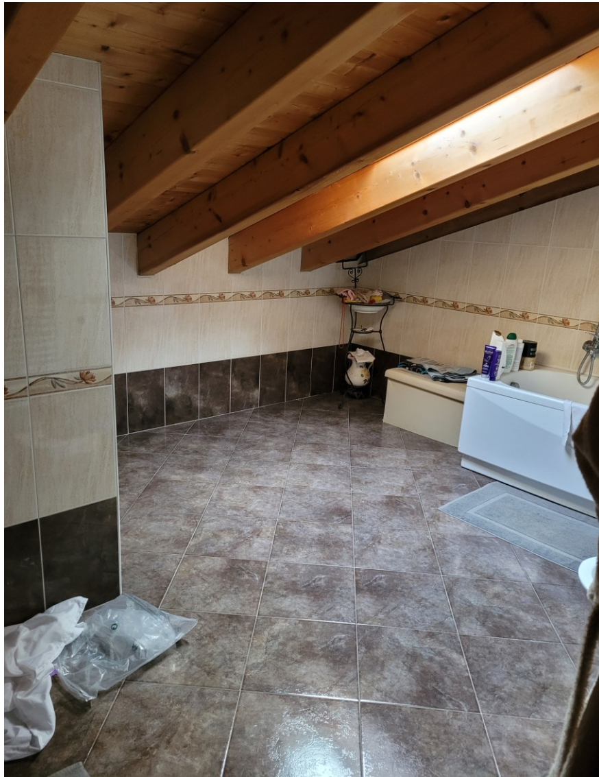
Locale sottotetto al piano primo (adibito a bagno)
