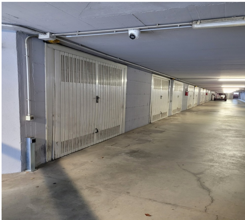
Corsello comune con il doppio accesso all'autorimessa (prime due basculanti) e ai locali al piano seminterrato
