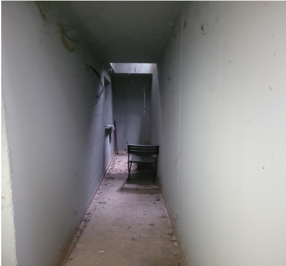
Cavedio sui locali cantina e lavanderia
