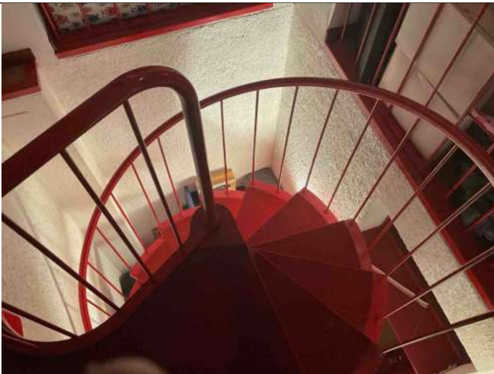
Scala di collegamento tra piano primo e sottotetto
