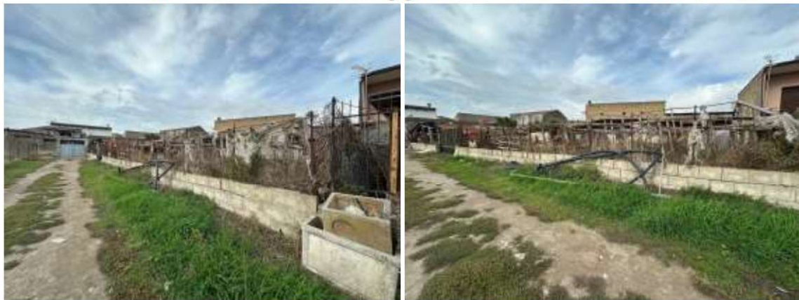
Foto 2-3: Vista del terreno dalla stradina interpodereale di accesso
