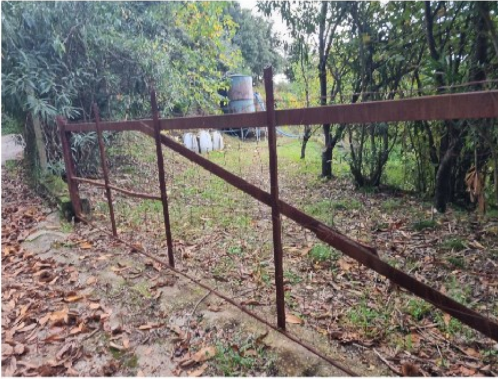
Foto n 15 (Ingresso particella 218)
