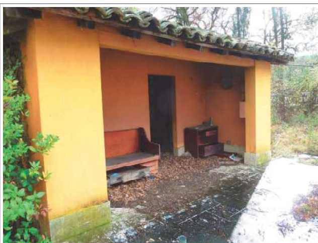
locale ripostiglio e sauna nei pressi della piscina
