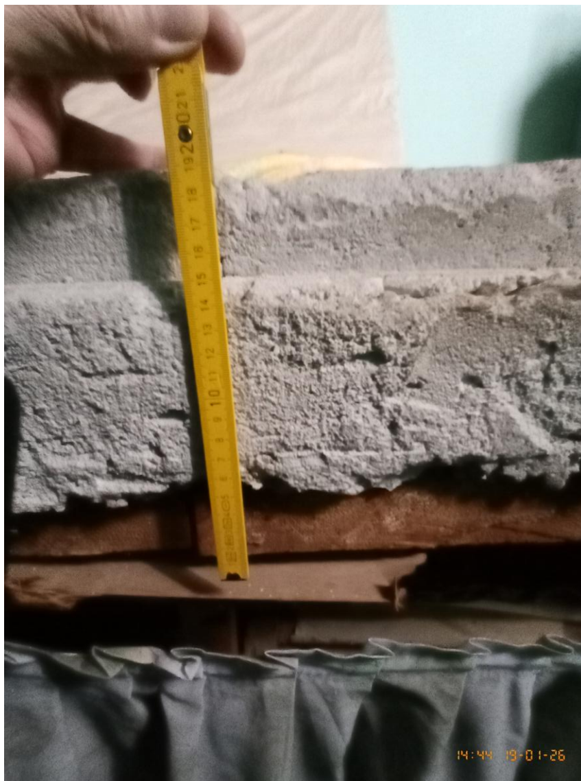
Sezione solaio interpianto
