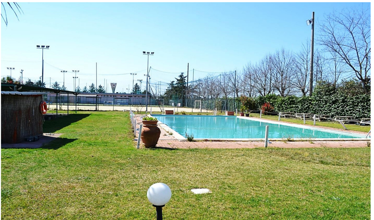
VISTA DELLA PISCINA GRANDE
