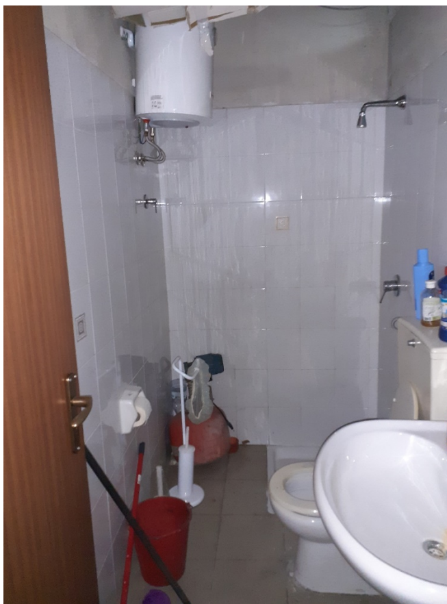
Foto nr. 17: bagno presente nel deposito
