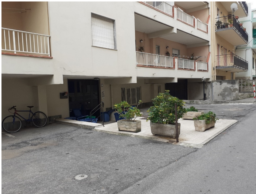
Foto nr. 13: particolare dell'ingresso allo stabile ove è ubicato il lotto in oggetto
