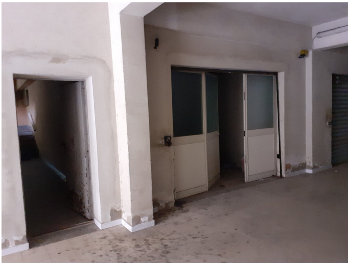
Foto nr. 15: particolare dell'ingresso al deposito
