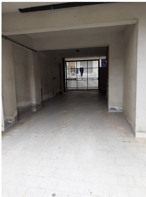
Foto nr. 14: particolare dell'ingresso carrabile
