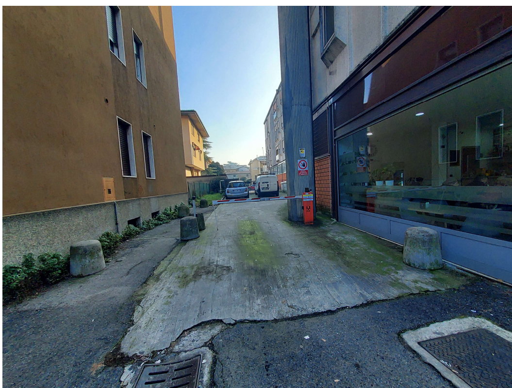
Foto dell'accesso al lastrico solare da Via Dante Alighieri
