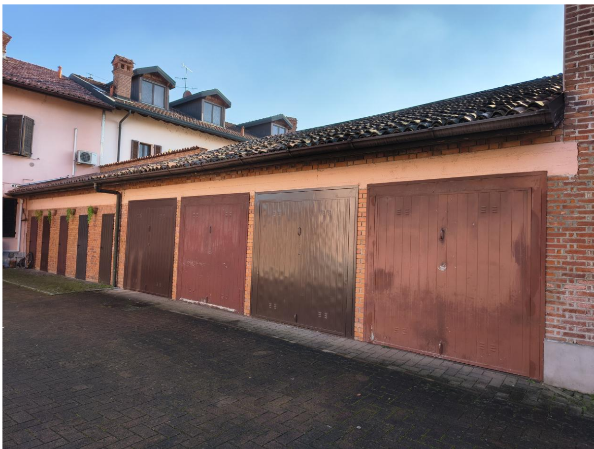
FOTO 8: fabbricato basso destinato a box e cantine entrostante cortile comune
