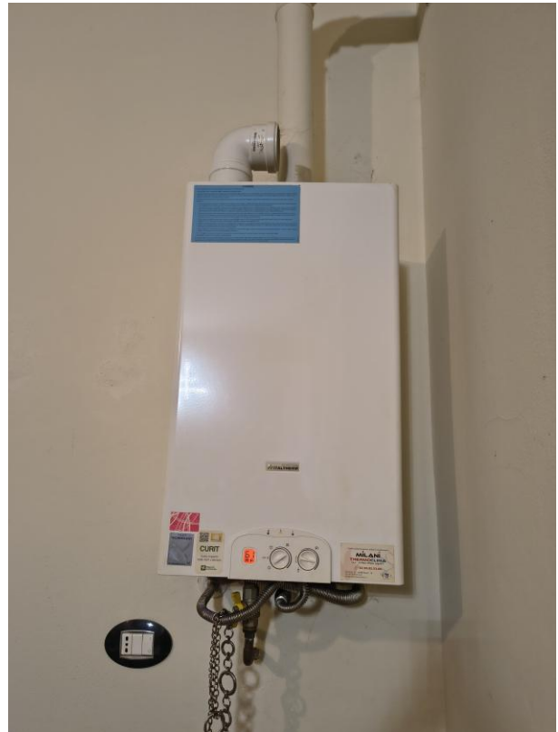
FOTO 14-15: quadro elettrico/termostato - caldaietta
