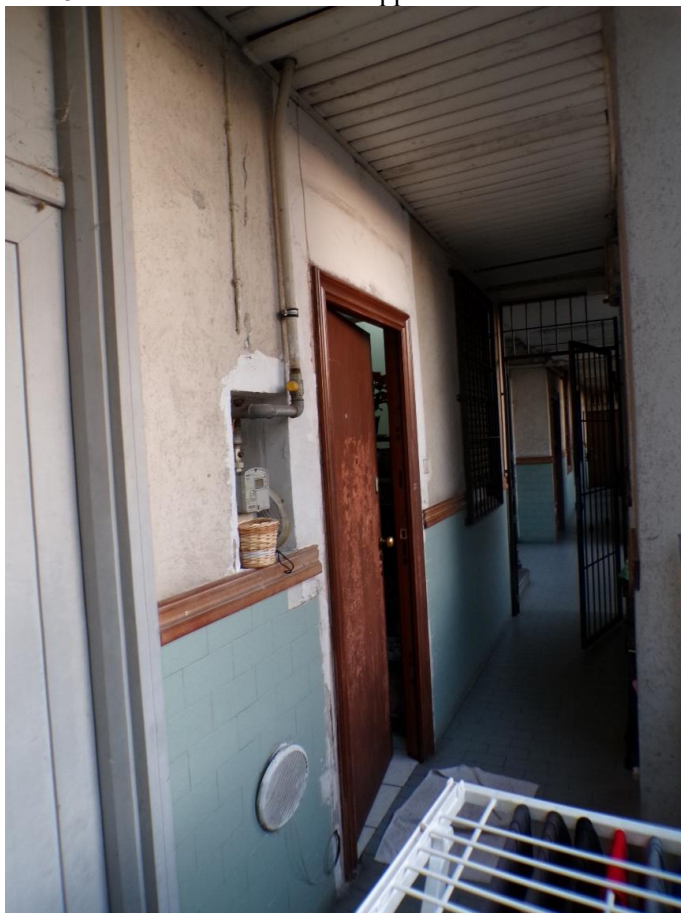
Foto 6: porta d'ingresso appartamento
