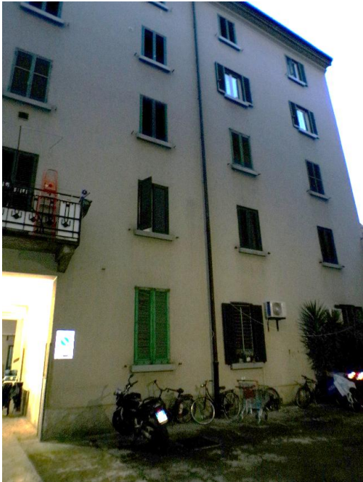
Foto 2: edificio scala C, foto da cortile tra scala B e scala C
