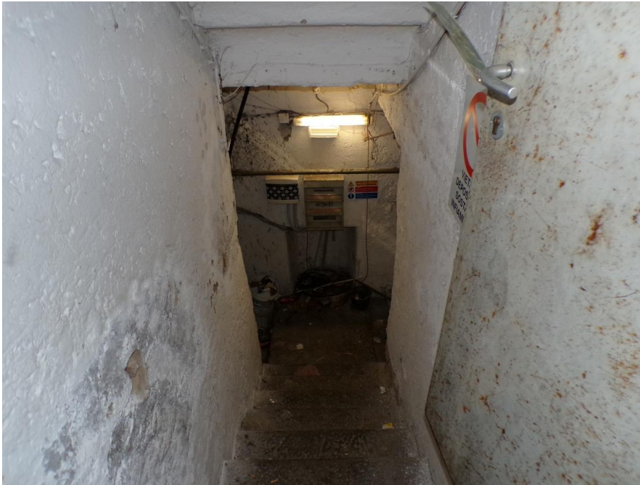
Foto 18: scala accesso cantine
