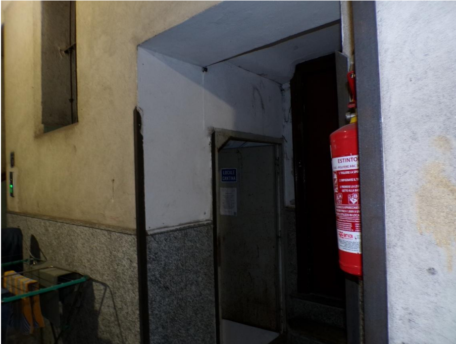
Foto 17: accesso piano cantinato
