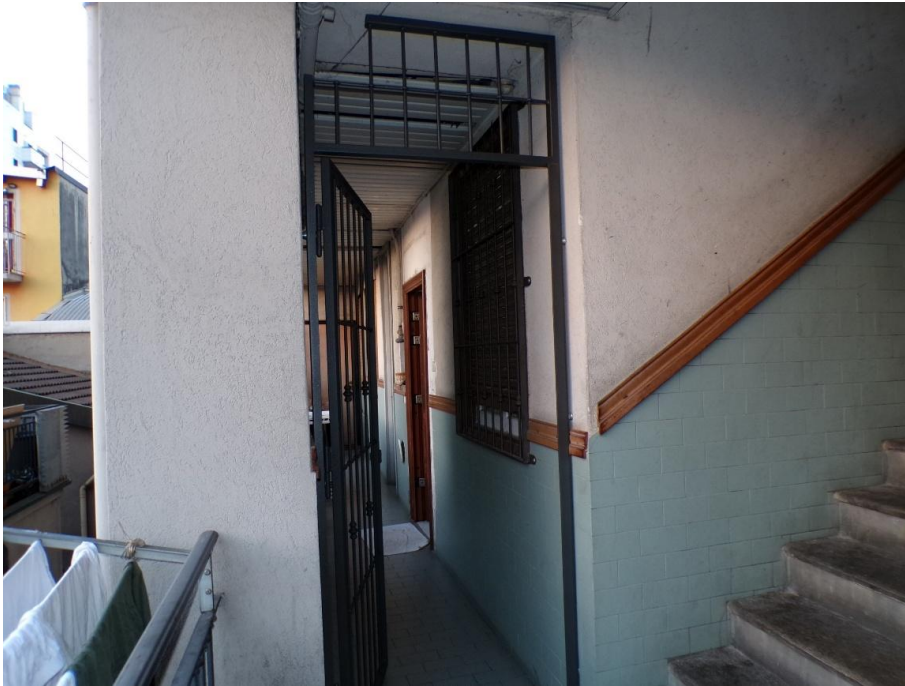
Foto 5: accesso ballatoio verso appartamento
