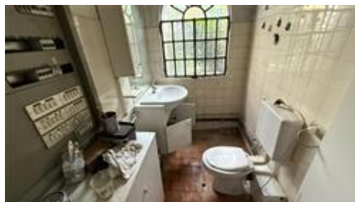
Vista interna piano terra
