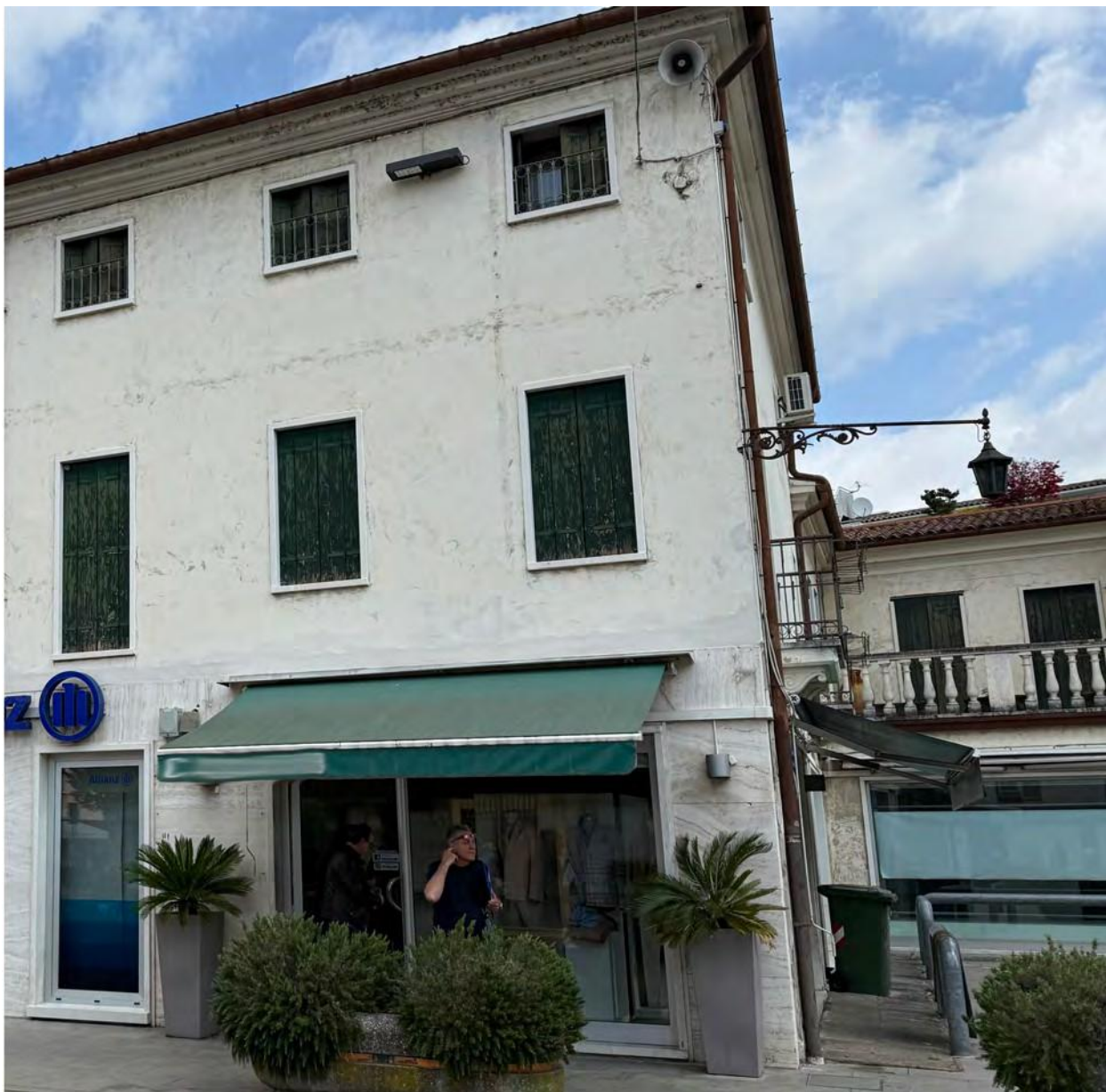
Foto C – Vista esterna da Piazza Umberto I
