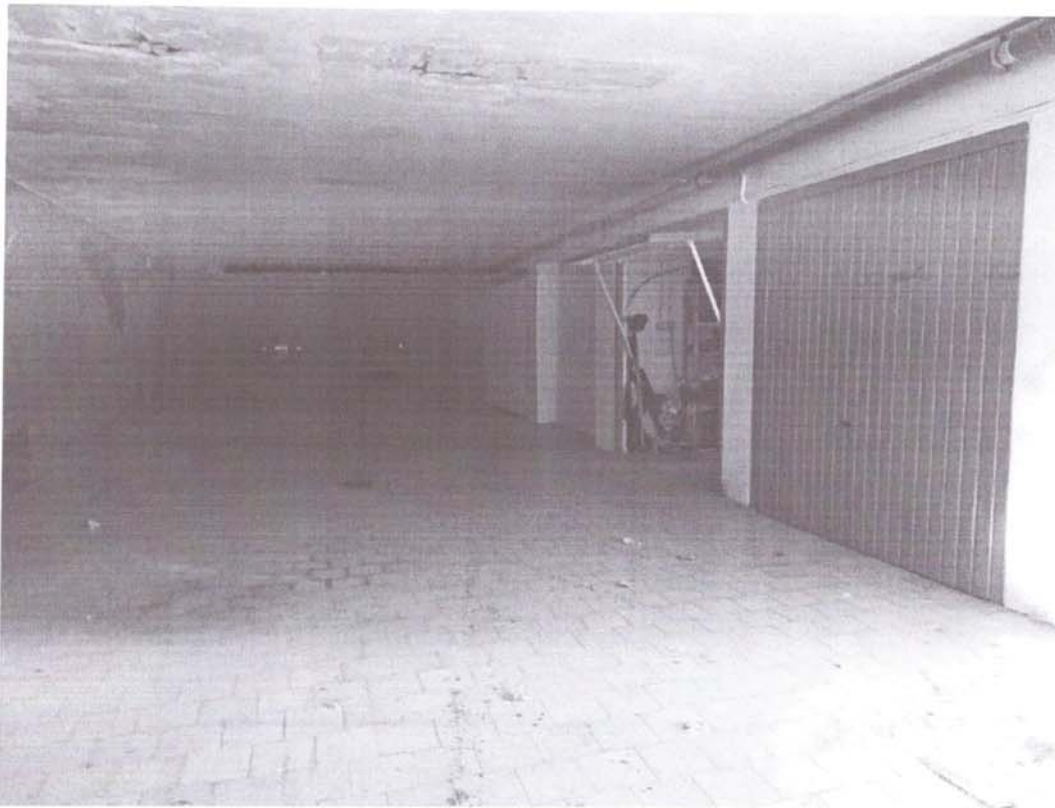
Foto 25 - Vista del tunnel di accesso ai garage
