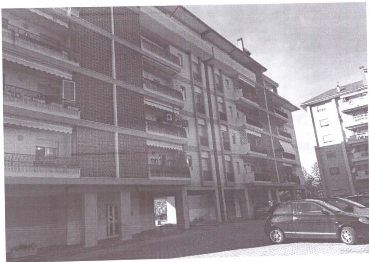
Foto 2 - Vista dell'edificio dal cortile condominiale
