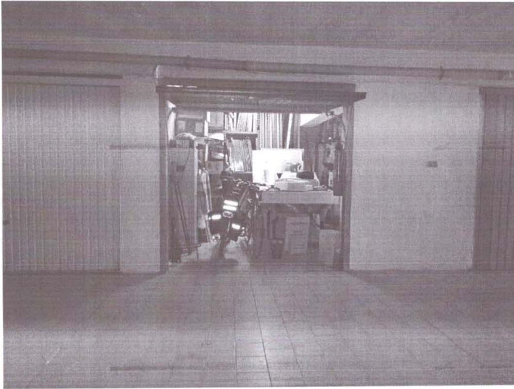
Foto 26 - Vista del garage sub 17
