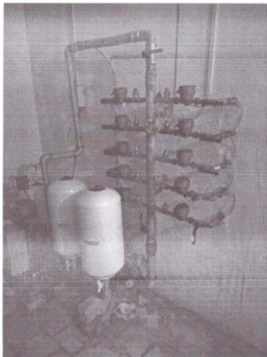
Foto 22 - Contatore dell'acqua
