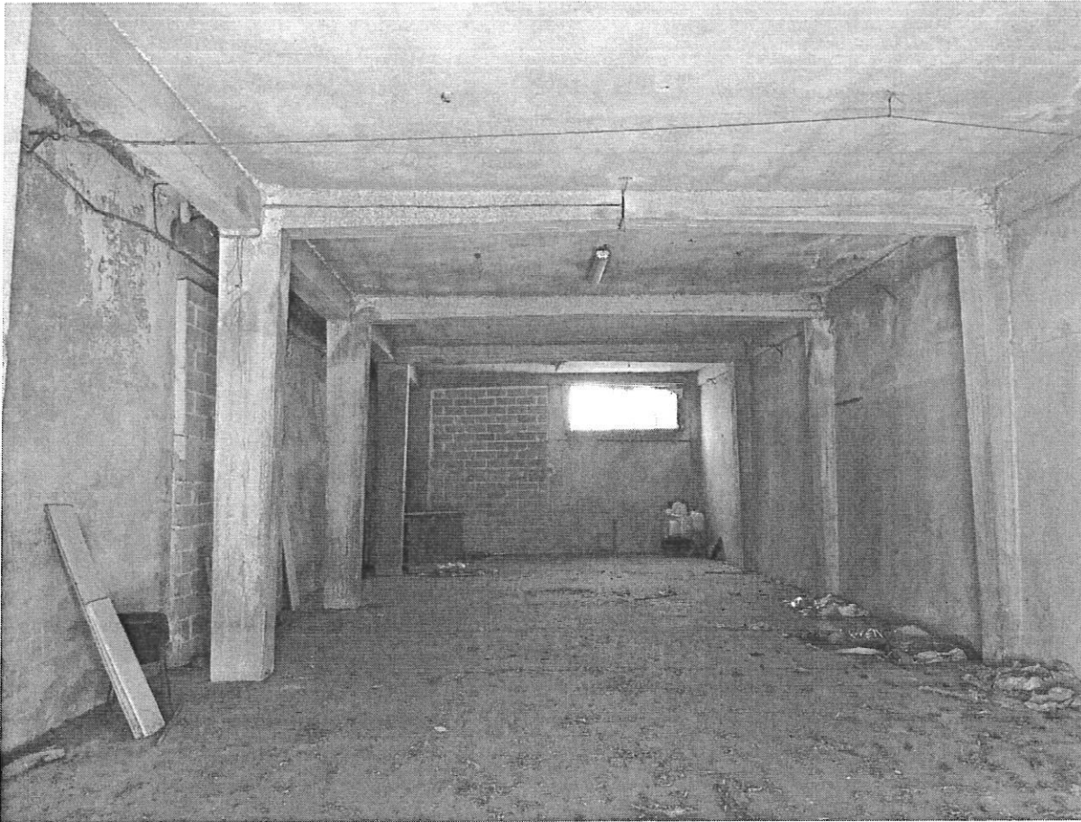
Foto interno locale area magazzino lato nord
