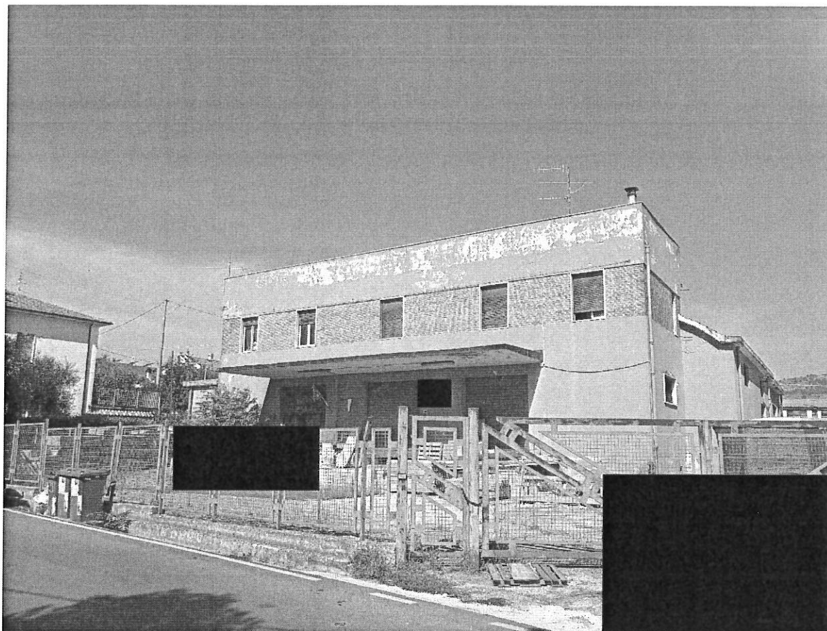
Foto esterna edificio lato sud/est
