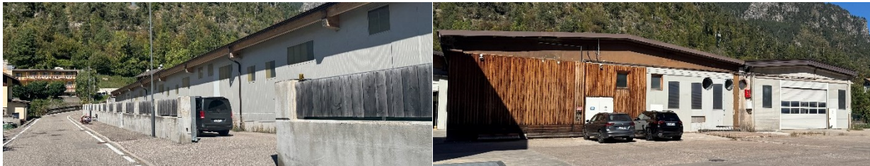
LOTTO 2 - COMPENDIO PRODUTTIVO P.E. 788 E P.F. 5017/6 C.C ZIANO CON IMPIANTO FOTOVOLTAICO IN COPERTURA POT. 190,44 kWp E UFFICIO P.E. 751/1 P.M. 6 C.C ZIANO Via Nazionale, 95 - 38030 Ziano di Fiemme (TN)
