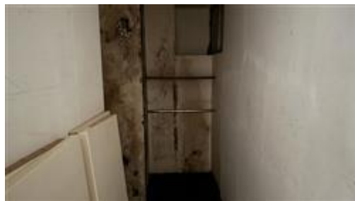
Vista interna negozio
