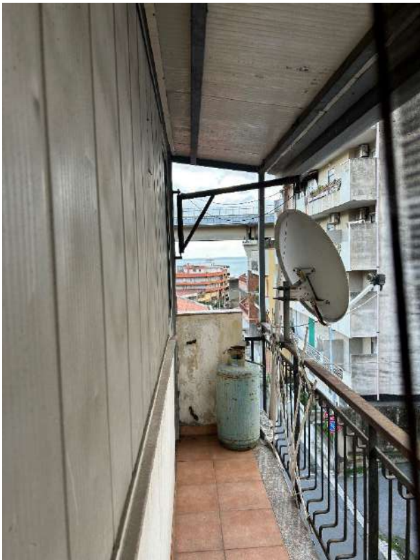
Figura 16 - Balcone piano secondo
