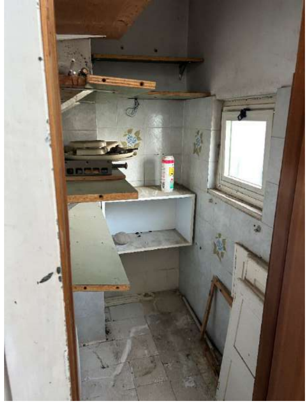
Figura 7 - Ripostiglio piano primo
