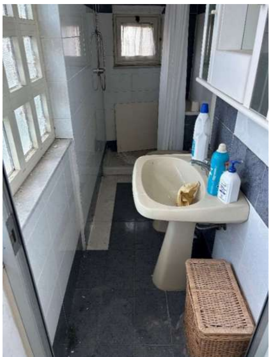
Figura 3 - Balcone chiuso in cui è stato ricavato il bagno
