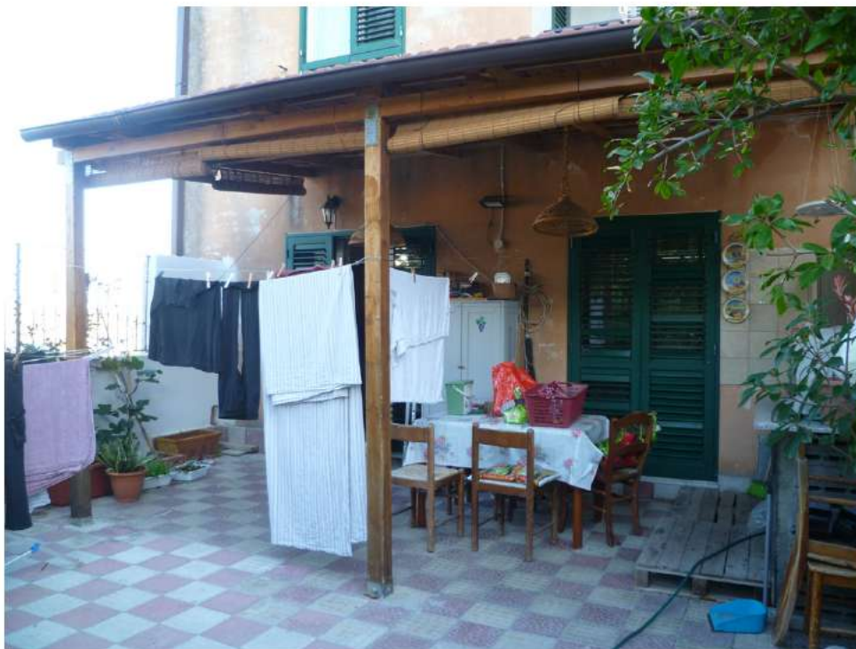
Foto n. 07 – Corte del fabbricato lato Ovest (con tettoia abusiva)
