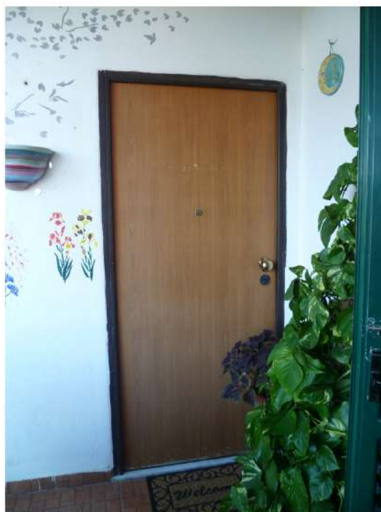
Foto n.02 – Ingresso dell'unità abitativa (PT)
