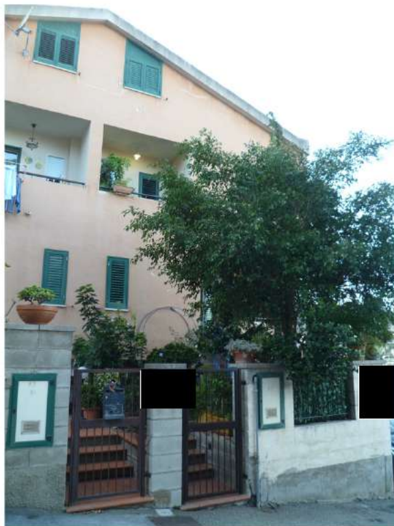
Foto n. 13 – Corte del fabbricato lato Est
