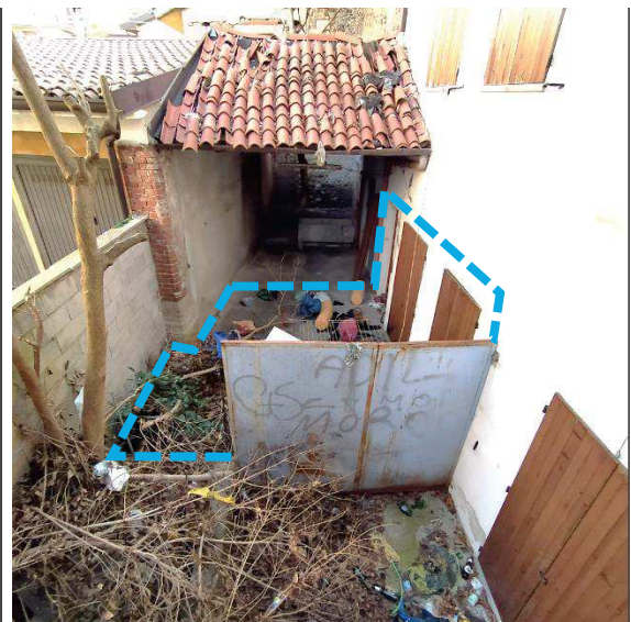
Vista lato interno
