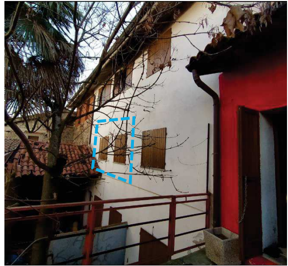
Finestre verso cortile retrostante
