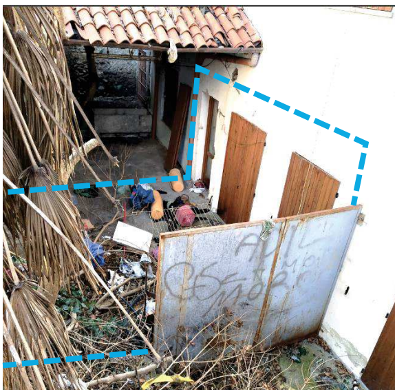
Vista lato interno
