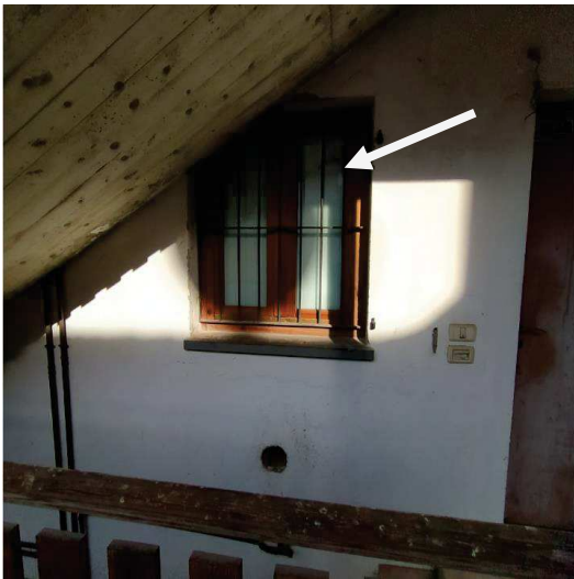
Finestra del sub. 712 – piano primo
