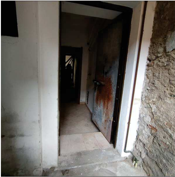
Ingresso al sub. 710
