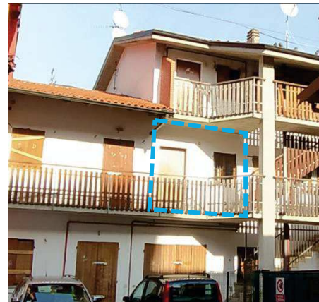
Sub. 711 - primo piano – vista esterna
