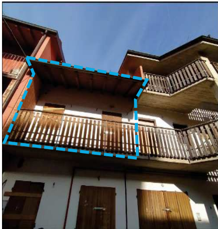
Sub. 4 - piano primo
