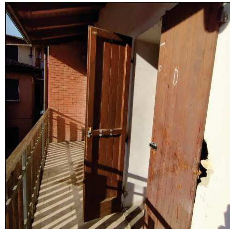
Ingresso Sub. 4 – piano primo
