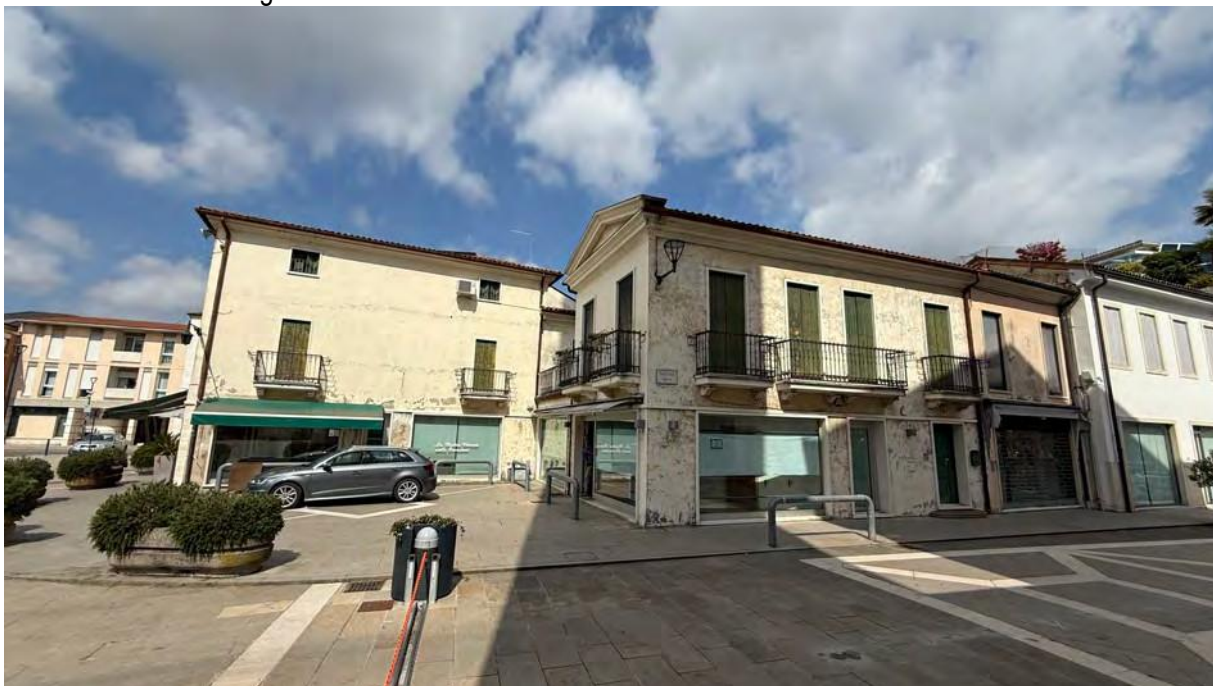
Foto A – Vista esterna da Piazza Umberto I
