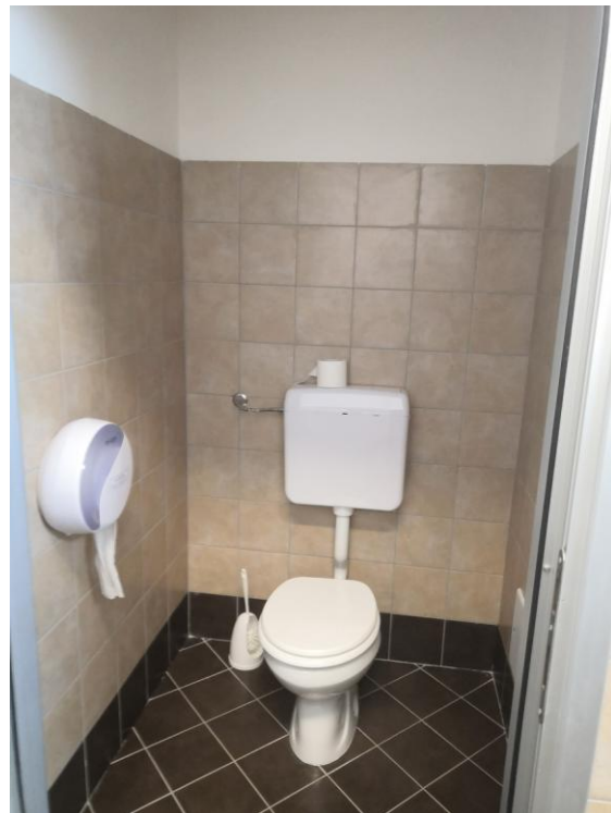
Foto n. 15 – w.c. uomo - CORPO A – P.T.
