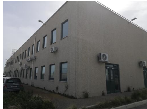
Foto n. 4 – prospetto CORPO A
