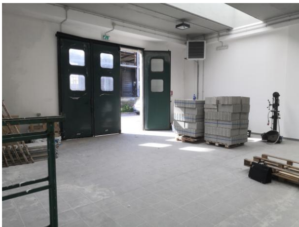
Foto n. 3 – area di lavoro
