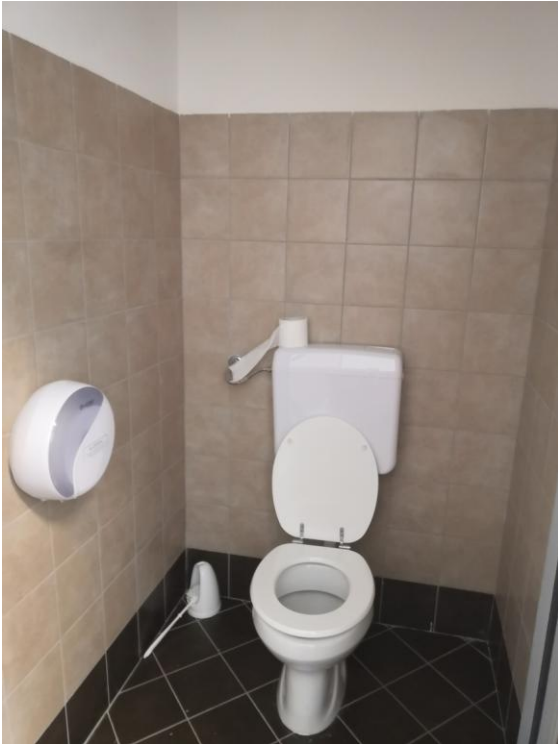
Foto n. 16 – w.c. uomo - CORPO A – P.T.
