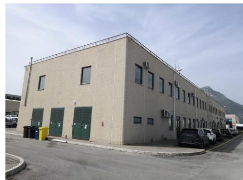
Foto n. 3 – prospetto CORPO A
