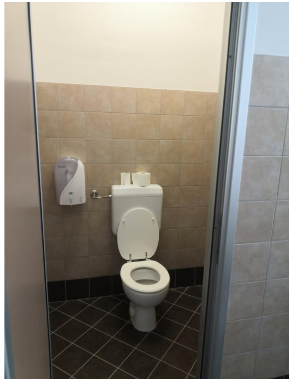
Foto n. 12 – w.c. - CORPO A – P.T.
