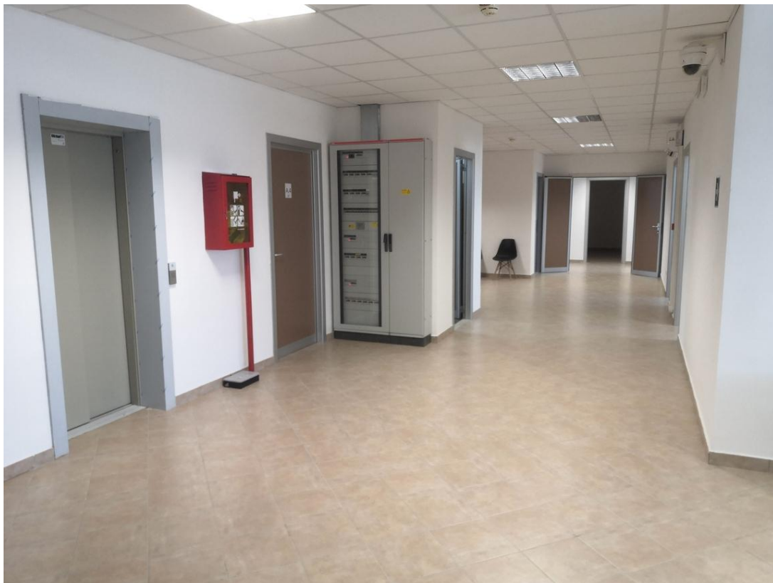
Foto n. 21– disimpegno - CORPO A – P.1°
