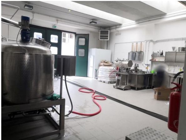
Foto n. 1 – area di lavoro
