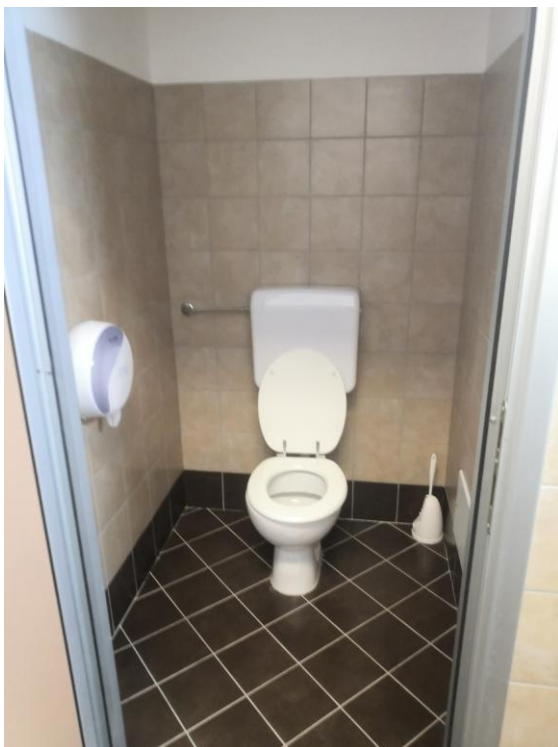
Foto n. 35 – w.c. uomo - CORPO A – P.1°
