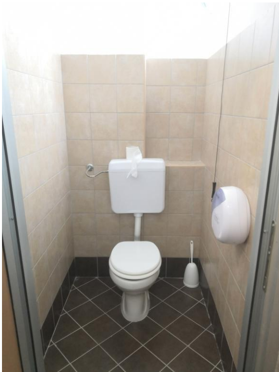
Foto n. 14 – w.c. uomo - CORPO A – P.T.
