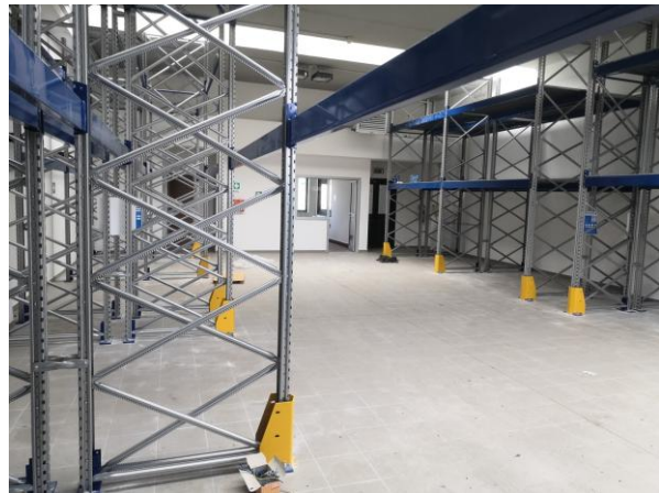
Foto n. 2 – area di lavoro
