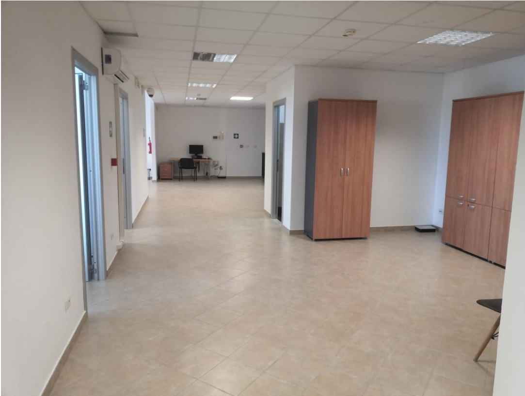
Foto n. 12 – disimpegno - CORPO A – P.T.
