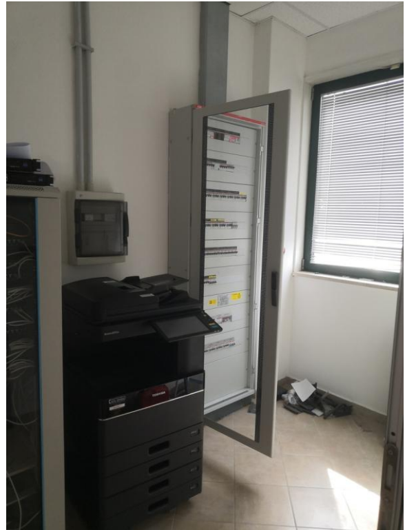
Foto n. 8 – locale tecnico - CORPO A – P.T.
