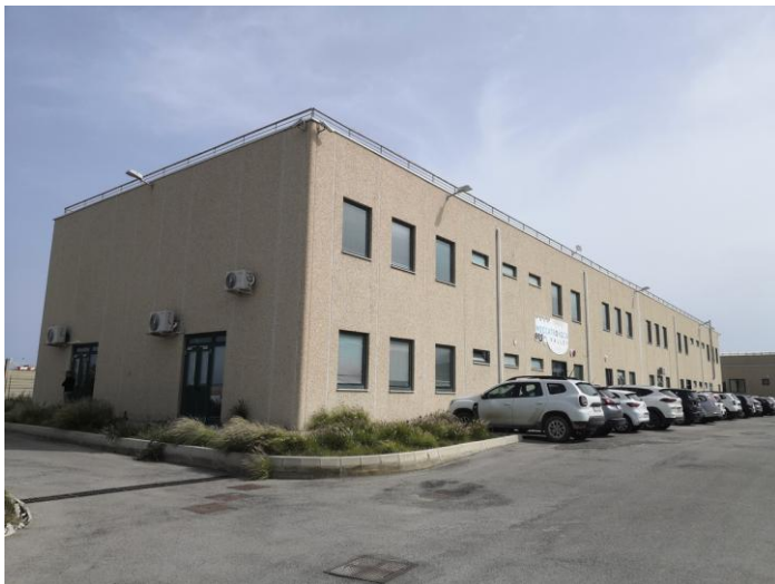
Foto n. 1 – prospetto CORPO A
