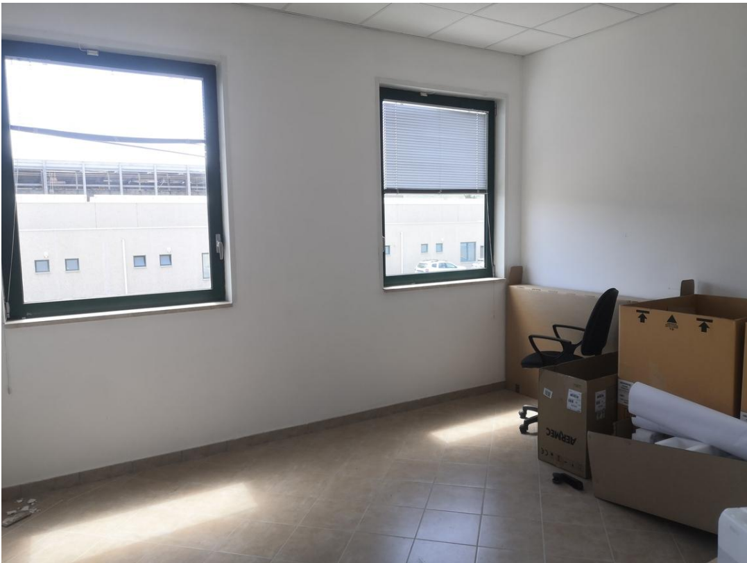
Foto n. 33 – Locale tecnico - CORPO A – P.1°
