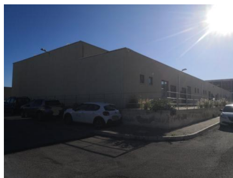
Foto n. 3 – prospetto CORPO B
