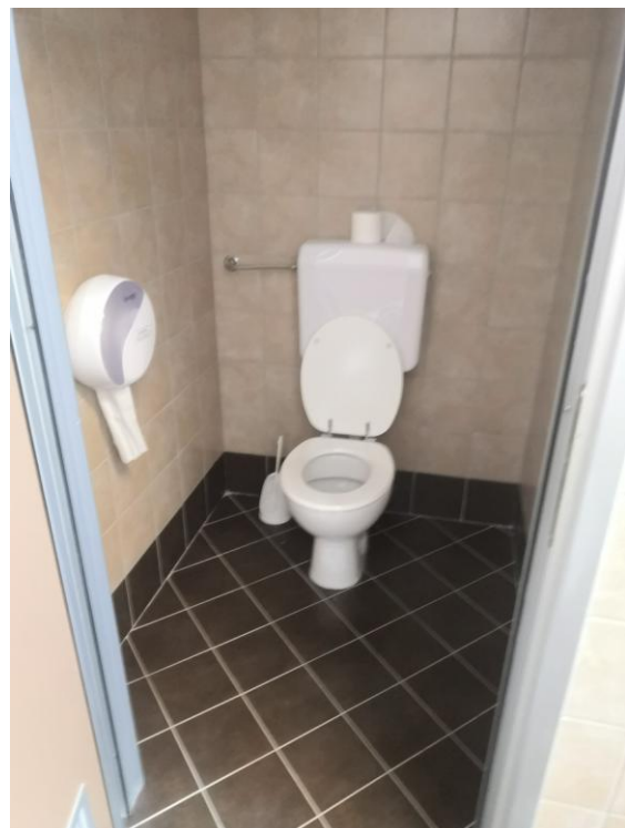
Foto n. 36 – w.c. uomo - CORPO A – P.1°
