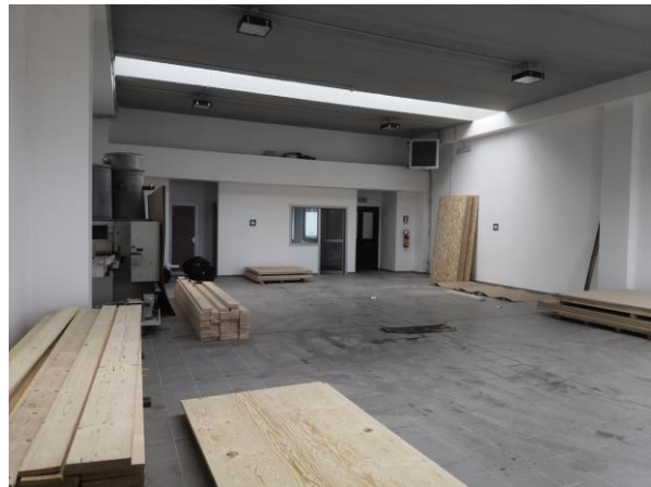
Foto n. 2 – area di lavoro
