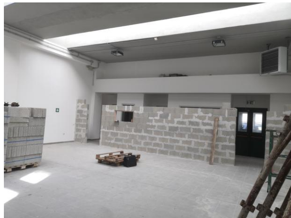
Foto n. 2 – area di lavoro
