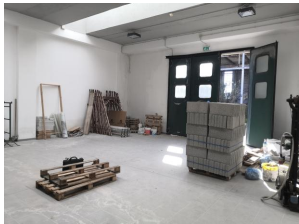
Foto n. 4 – area di lavoro
