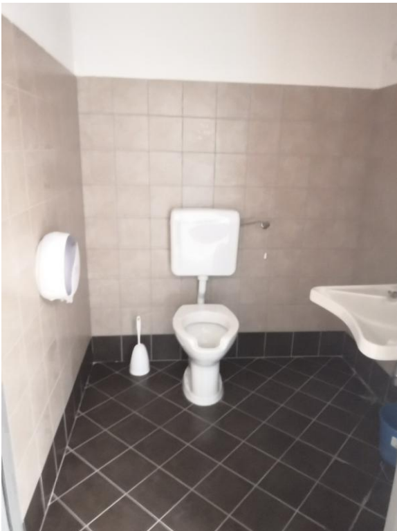
Foto n. 21 – w.c. H - CORPO A – P.T.
