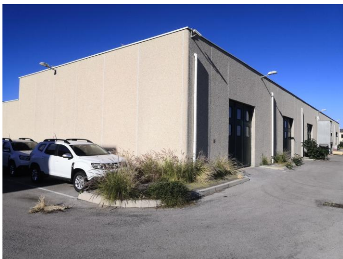
Foto n. 2 – prospetto CORPO B
