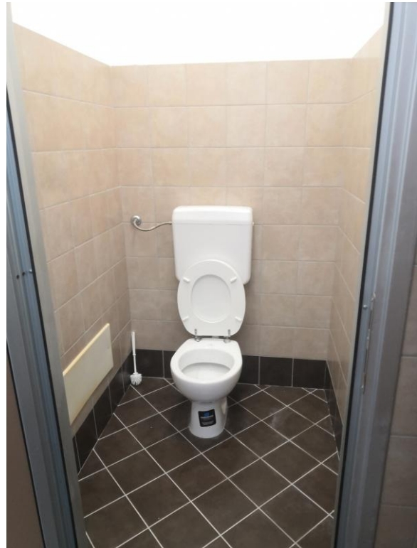
Foto n. 24 – w.c. - CORPO A – P.1°.
