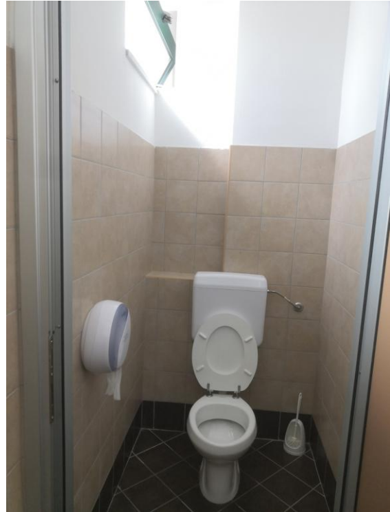
Foto n. 18 – w.c. donne - CORPO A – P.T.
