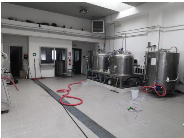
Foto n. 3 – area di lavoro
