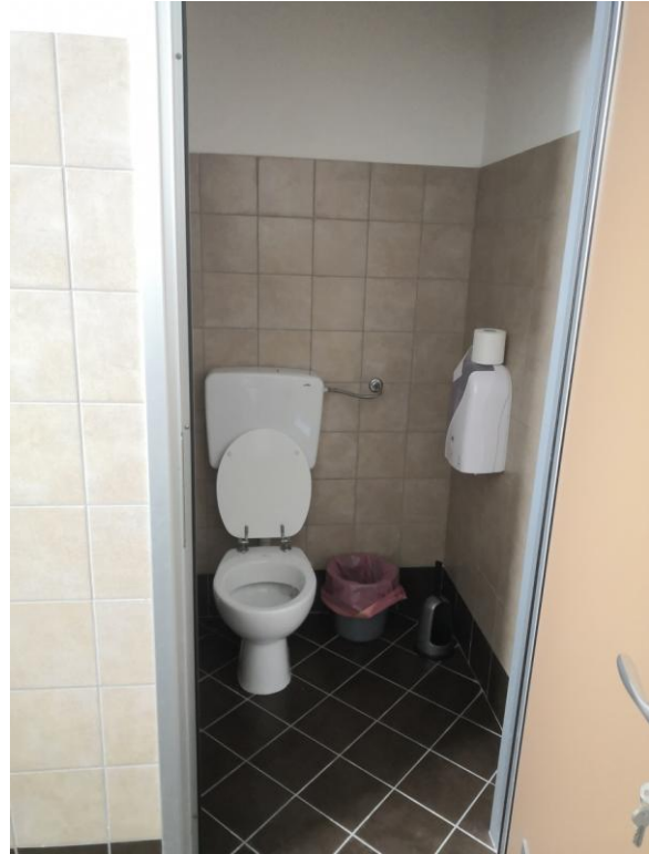
Foto n. 10 – w.c. - CORPO A – P.T.
