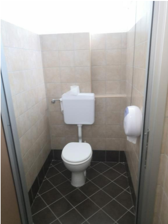
Foto n. 37 – w.c. uomo - CORPO A – P.1°
