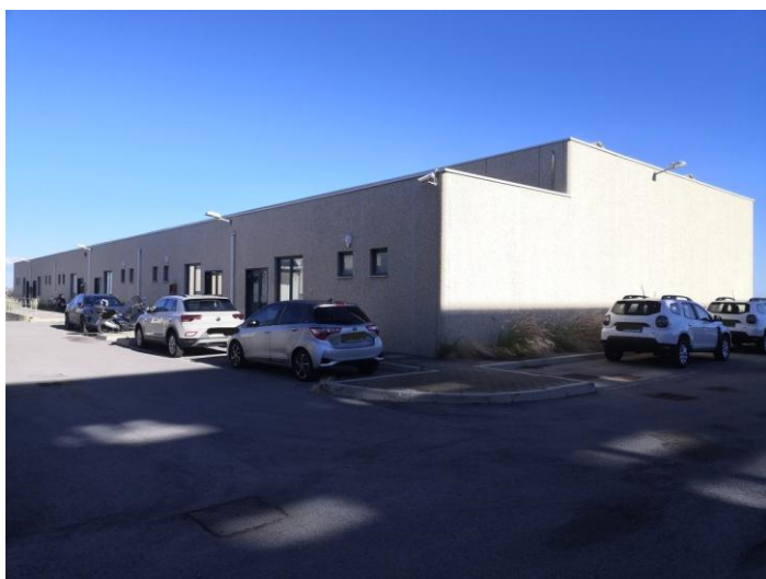
Foto n. 1 – prospetto CORPO B
