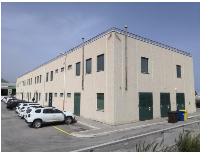
Foto n. 2 – prospetto CORPO A
