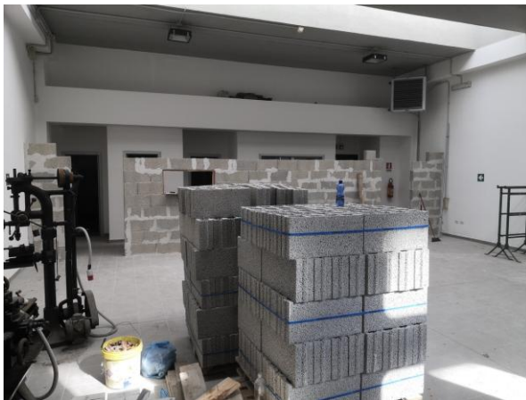
Foto n. 1 – area di lavoro
