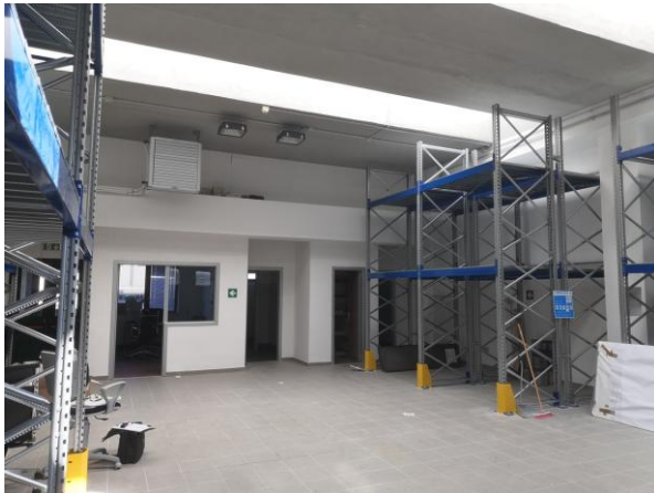
Foto n. 1 – area di lavoro
