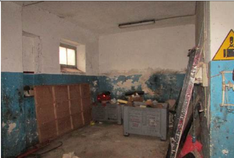
Foto 1 - Lotto 1 - Corpo 3 - Magazzino -
