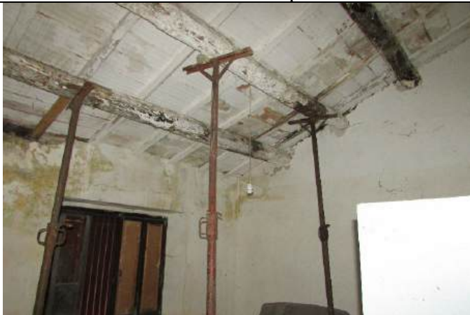
Foto 3 – Interno Lotto 1 - Corpo 1 Casa Rurale -
