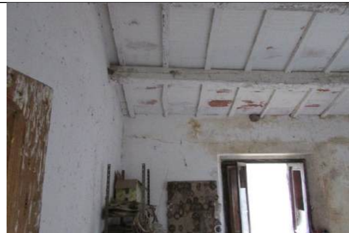
Foto 2 – Interno Lotto 1 - Corpo 1 Casa Rurale -
