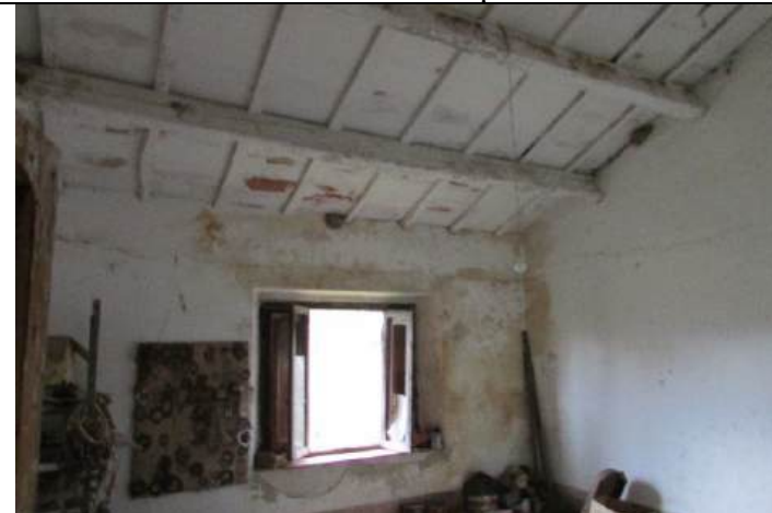
Foto 4 – Interno Lotto 1 - Corpo 1 Casa Rurale -
