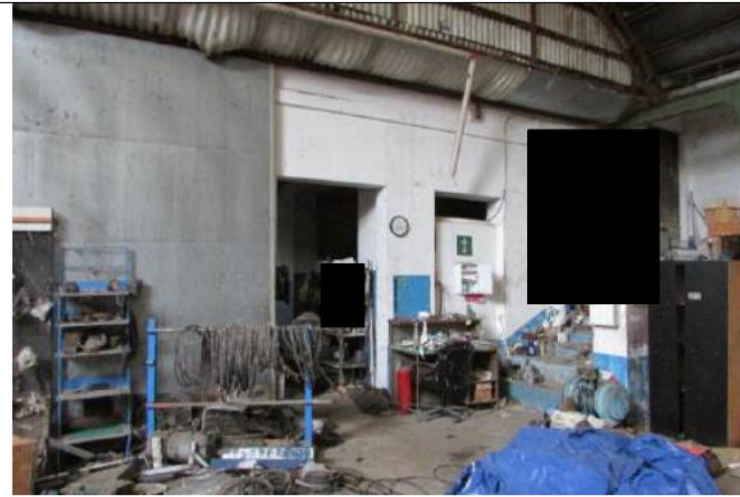
Foto 2 – Interno Lotto 1 - Corpo 2 Officina Meccanica -
