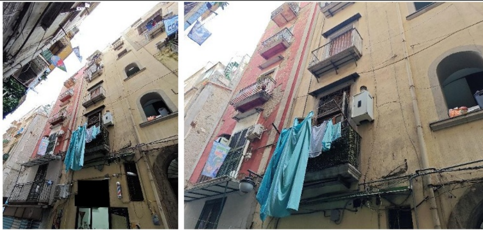
Foto n. 1/2 vista della Facciata d'ingresso e dell'unità
