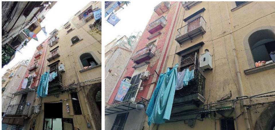
Foto n. 1/2 vista della Facciata d'ingresso e dell'unità
