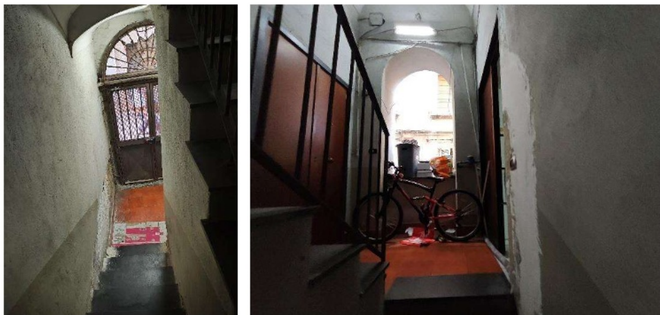
Foto n. 3/4 vista vano scala, ingresso
