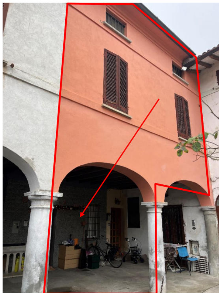
Foto ingresso all'abitazione da cortile interno comune
