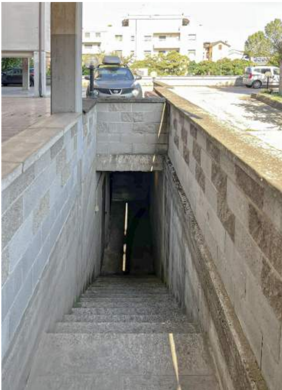
Vista corte interna – vista scala frontale per accesso a locale seminterrato
