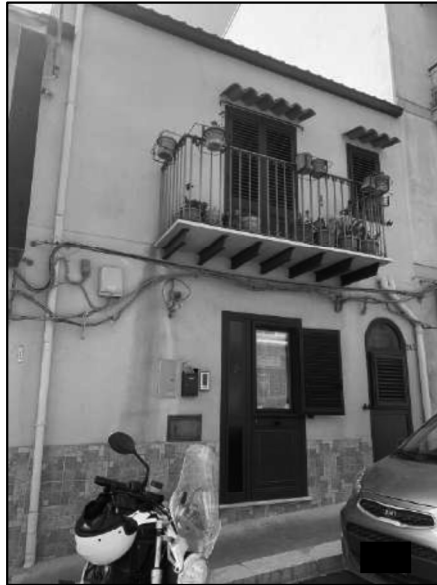
Foto n. 1 – Prospetto sulla via Provinciale
